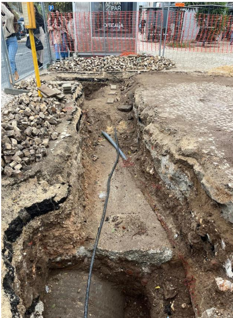
Figura 1 – Sondagens efetuadas em Outubro 2024 – Identificação da conduta elevatória CE3 de Alcântara do sistema de saneamento em alta
