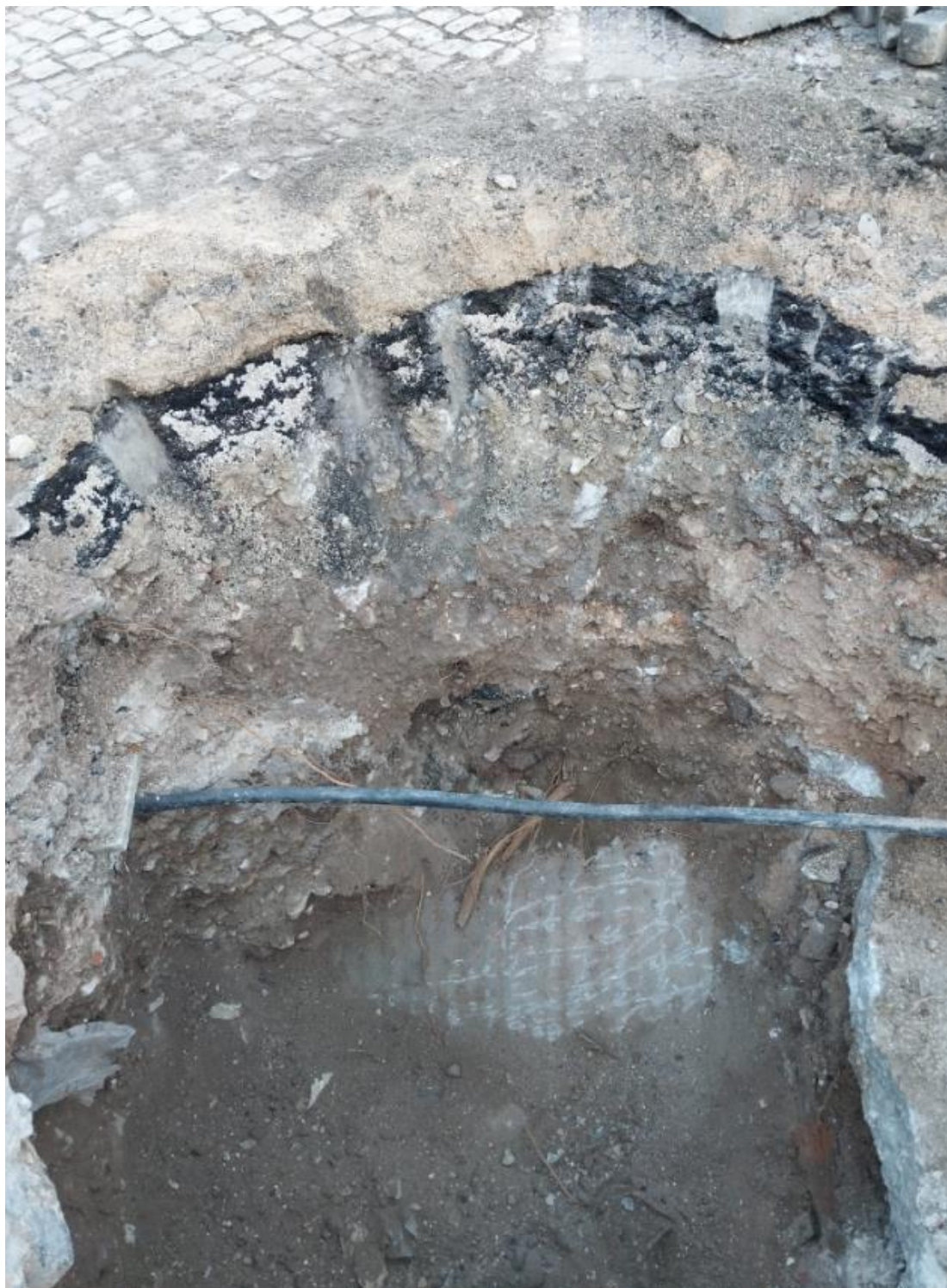
Figura 3 – Sondagens efetuadas em Outubro 2024 -Identificação da conduta elevatória CE3 de Alcântara do sistema de saneamento em alta
