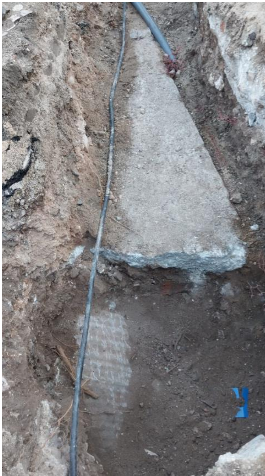
Figura 2 – Sondagens efetuadas em Outubro 2024 – Identificação da conduta elevatória CE3 de Alcântara do sistema de saneamento em alta
