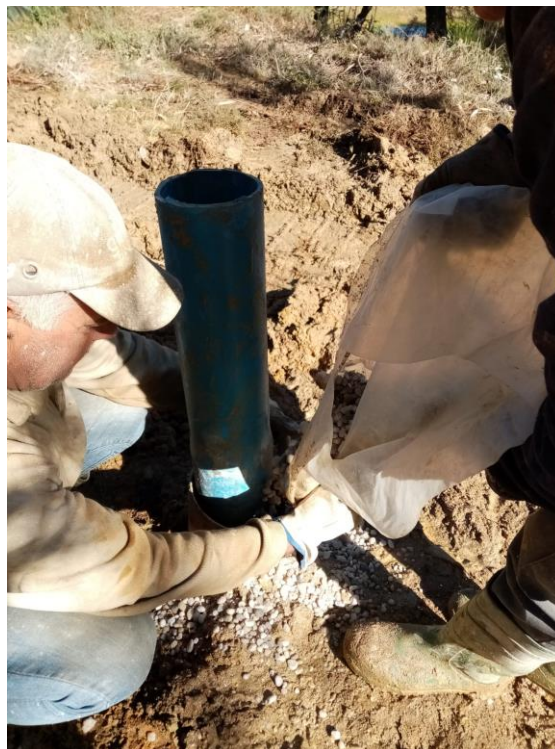
Figura 5. Colocação areão calibrado.
