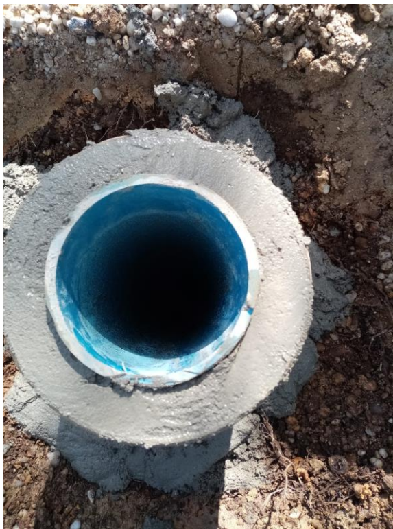
Figura 4. Isolamento com calda de cimento.
