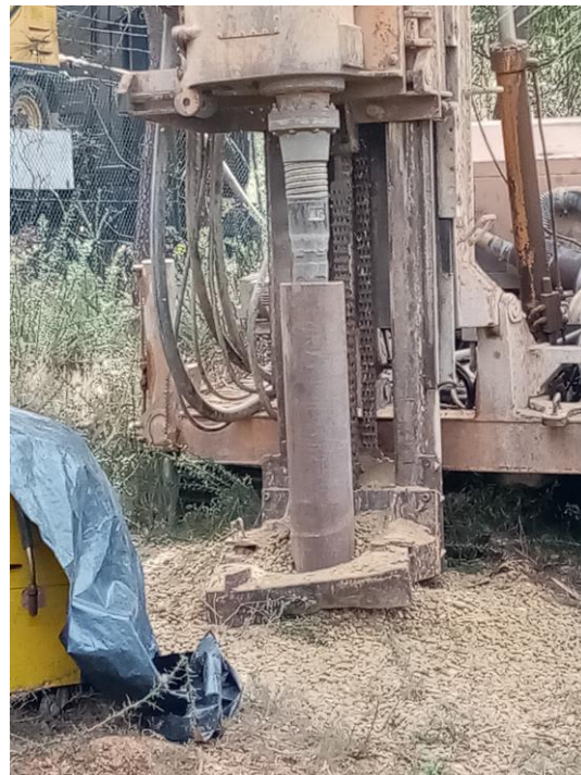
Figura 3. Instalação da tubagem em ferro na zona inicial e mais alterada.
