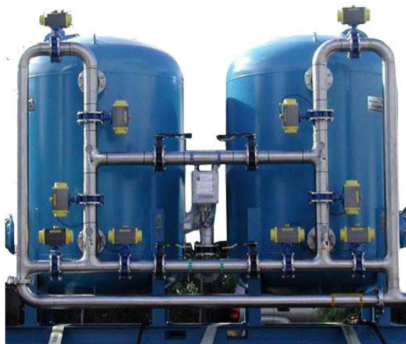
Figura 4 - Filtros de pressão.
