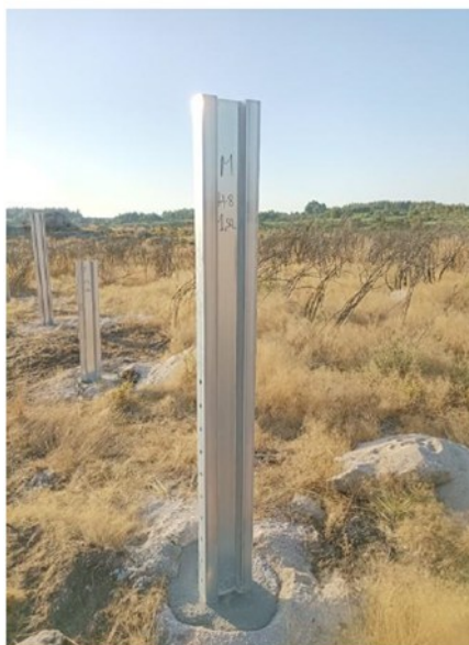
Fotografia 2– Exemplificação das estruturas – micro-estacas de betão
