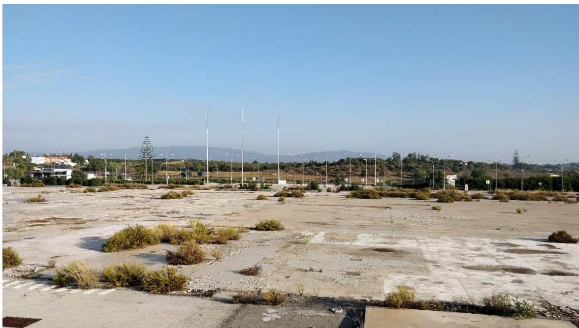
Figura 4.2.2 - Vista geral da área do projeto, que se encontra, na sua maioria, pavimentada.
