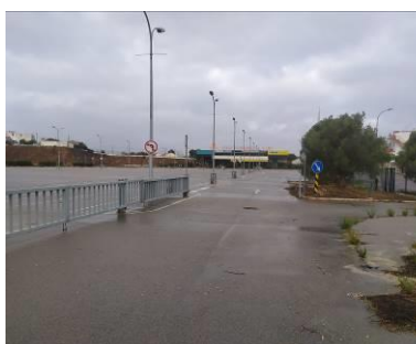
Fotografia 1. Enquadramento parcial da AI obtido desde o acesso sudeste.
