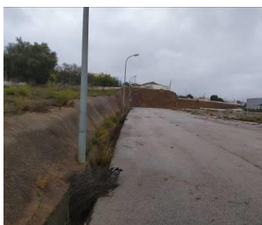
Fotografia 4. Perspetiva dos acessos e taludes impermeabilizados.
