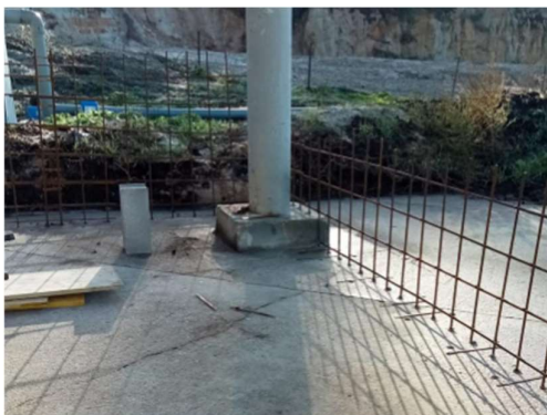
Foto 5 – Construção de murete de contenção
