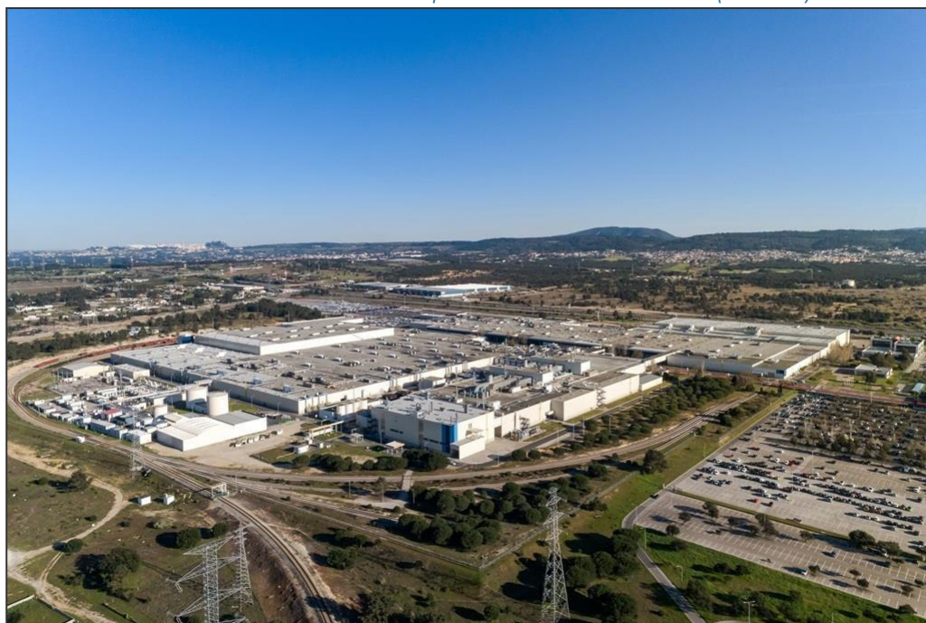
Foto III.1 – Vista aérea do complexo industrial da VWA (NW-SE)
