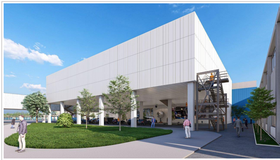
Figura III.11 – Simulação 3D da extensão do edifício 3 onde ficará alojado o novo forno eléctrico da cataforese
