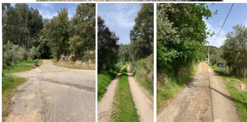
Figura 4.15.8. Área de acessos existentes.
