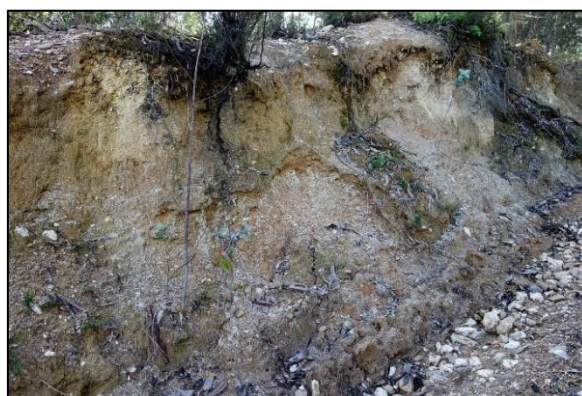
Figura 4.4.20. Fotografias dos taludes ao longo do acesso.
