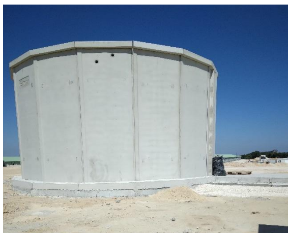
Figura 3.1.7. Exemplo de um reservatório de água de 500 m 3 (em fase de obra).
