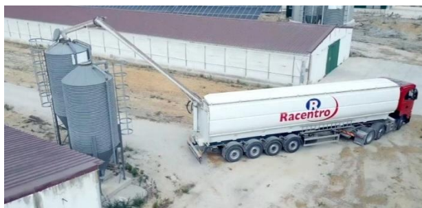
Figura 3.6.3. Abastecimento de silos numa instalação avícola do Grupo Lusiaves.
