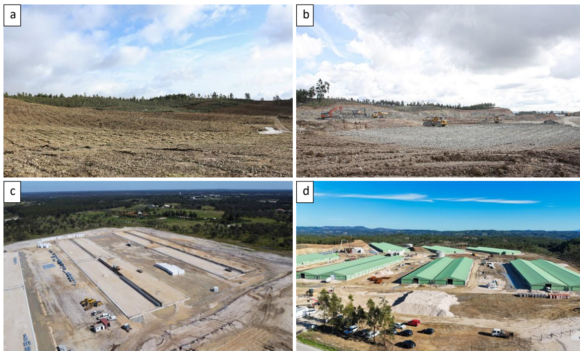
Figura 3.5.1. Exemplo de uma frente de obra ao longo da fase de construção: a) desmatamento; b) movimentação de terras; c) início das obras de construção; e d) final das obras de construção.
