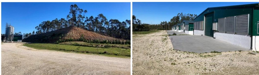
Figura 3.2.2. Exemplo de área exteriores pavimentadas em ABGE e betão.
