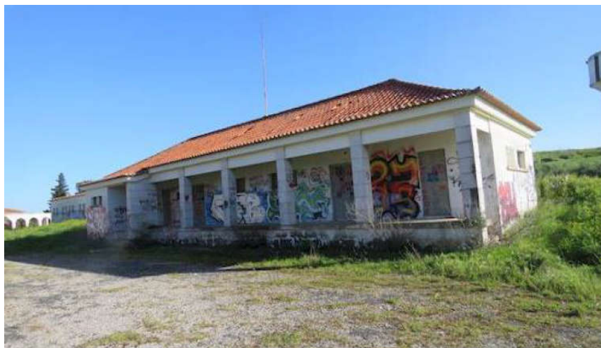
Fotografia 1 – Edifício abandonado, na área afeta à antiga Estação Radionaval.
