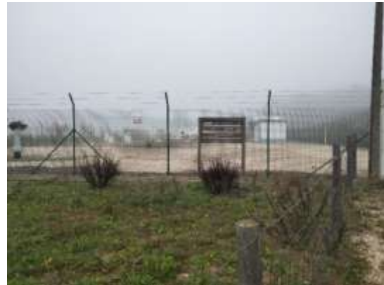
Estação de Regulação de Pressão e Medição da Abridada: GRMS 1319, onde se prevê a ligação do gasoduto
