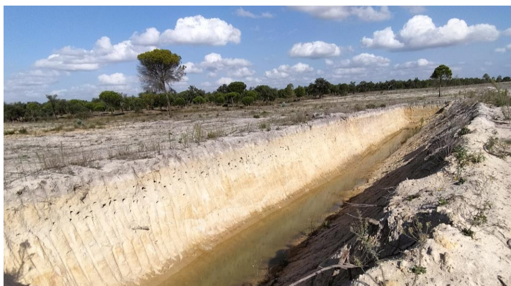
Fotografia 3: Talude de escavação na exploração Nucho das Figueiras.
