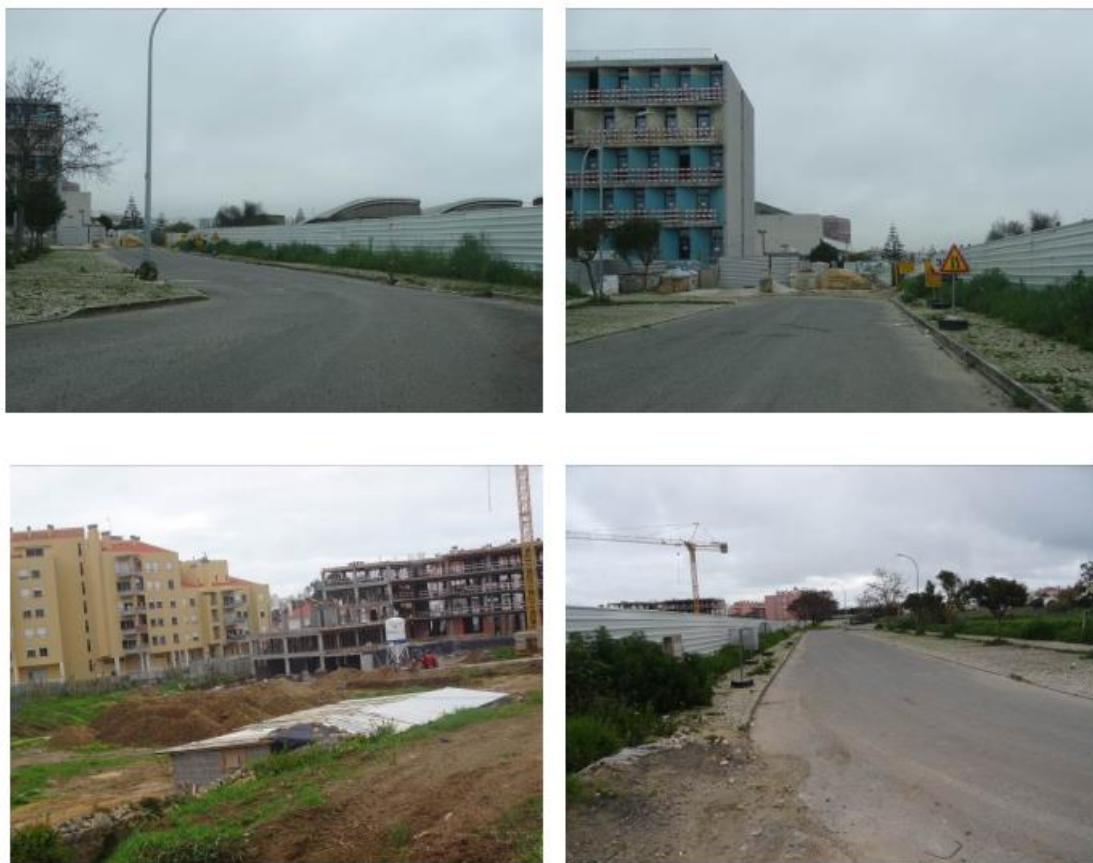
Figura 4.2.25 - Local da futura rotunda I18.
