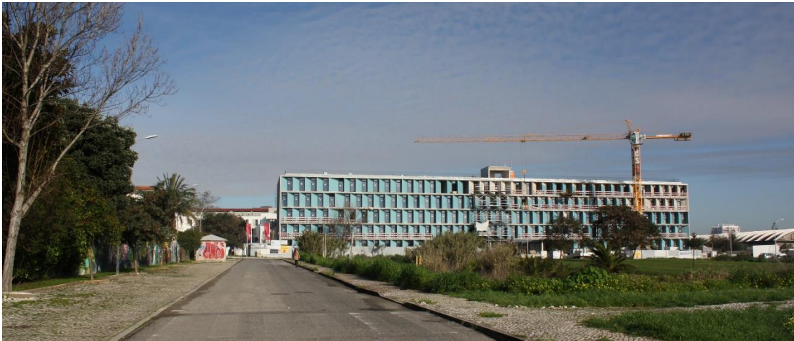
Figura 5.14.9 – Subunidade 78a1, edifício em construção na Rua Alfândega Velha.
