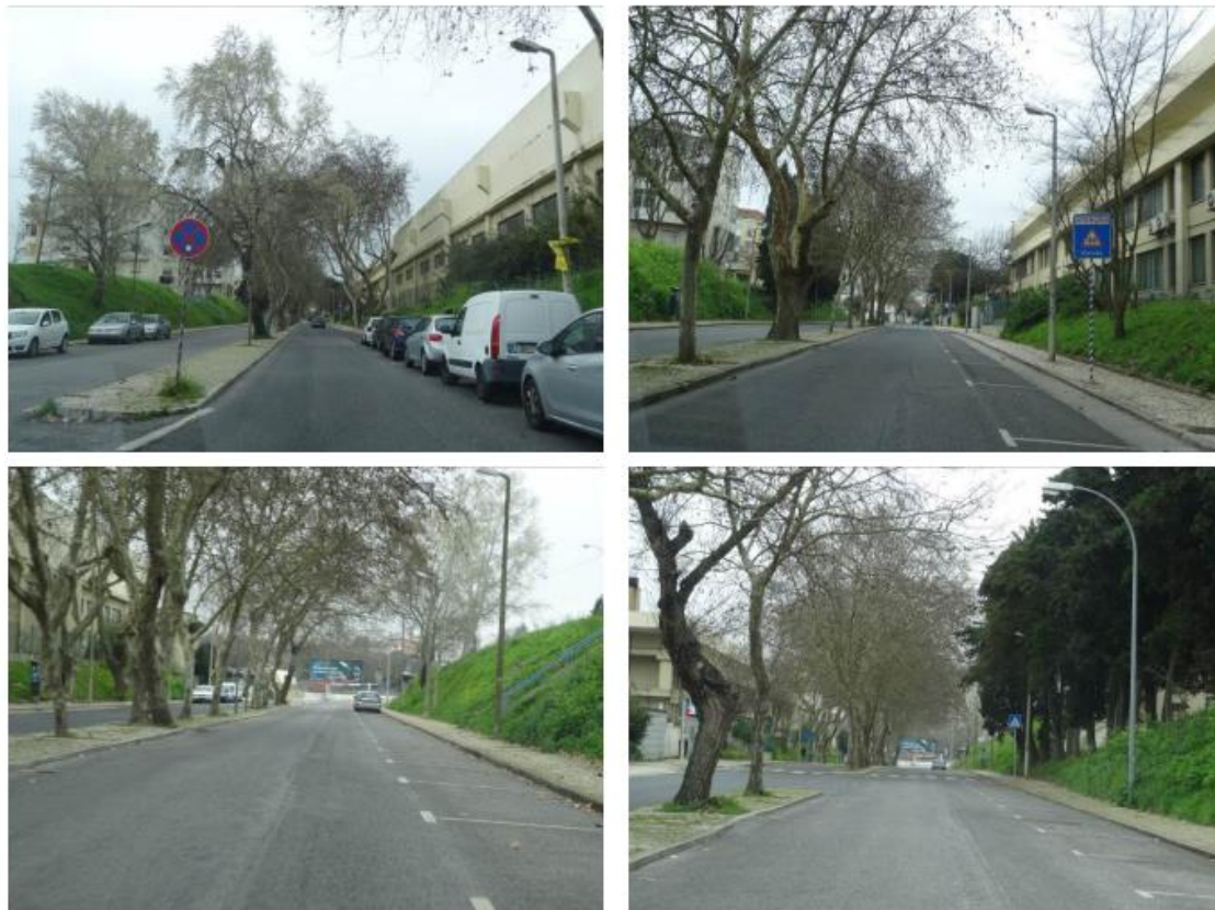
Figura 4.2.28 - Troço S1 – Secção da Rua Fundação de Oeiras entre a Rua Eng. Guilherme Gomes dos Santos e a Rotunda I1.
