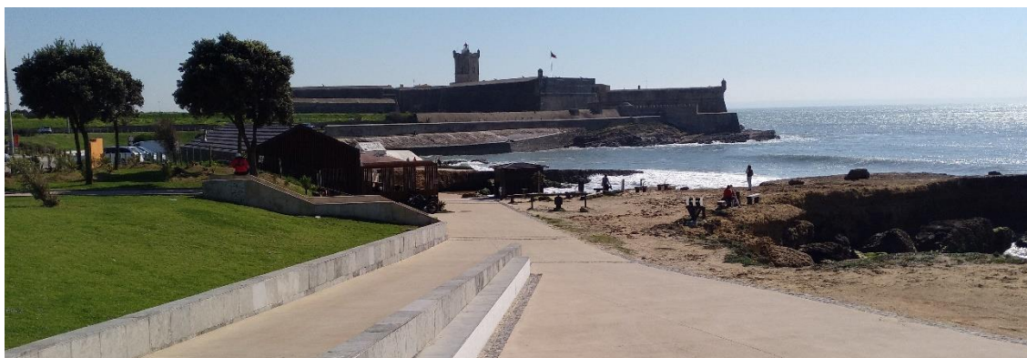
Figura 5.14.16 – Subunidade 78a3, Forte de São Julião da Barra.
