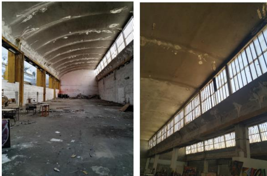
Figura 4.3.1 – Exemplo dos edifícios a demolir.
