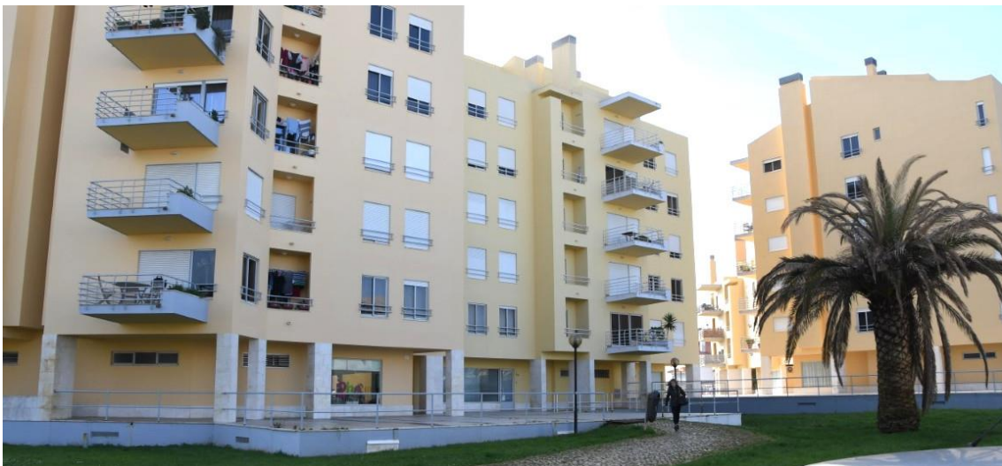
Figura 5.14.10 – Subunidade 78a1, edifícios a sul da Fundação de Oeiras.
