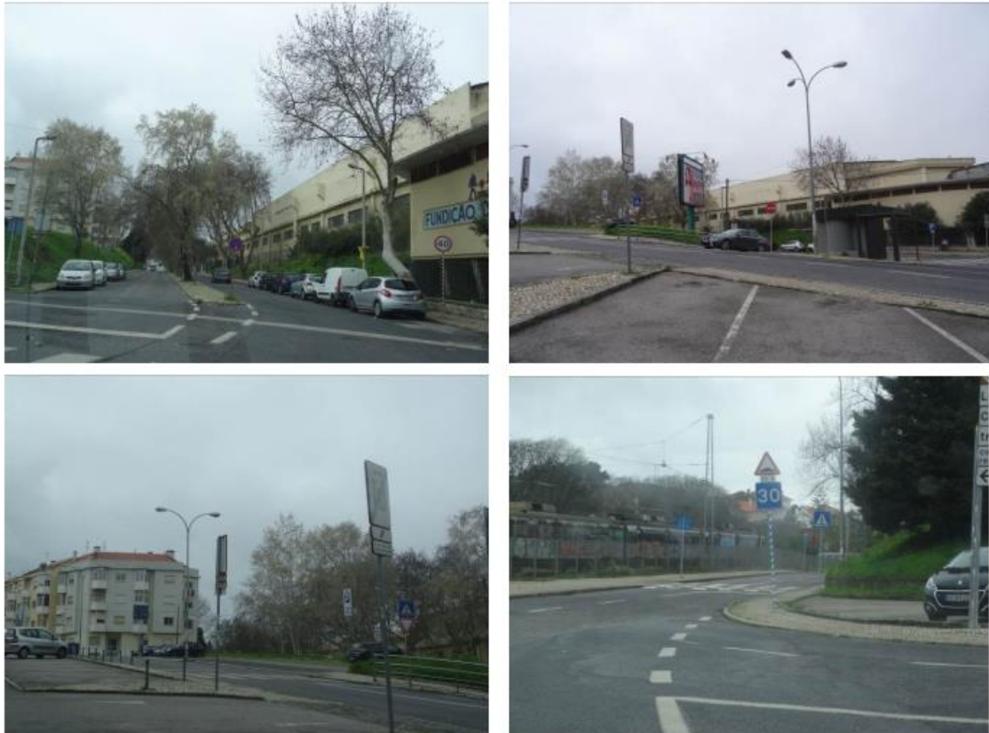
Figura 4.2.17 - Atual interseção de nível entre a Rua Fundação de Oeiras e a Av. Infante D. Henrique.
