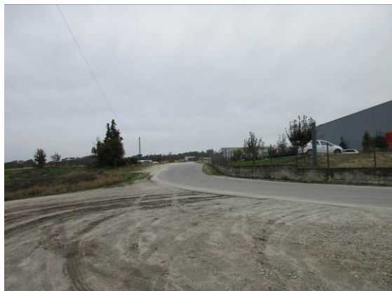
Fotografia 13 - Local de implantação da rotunda 3.
