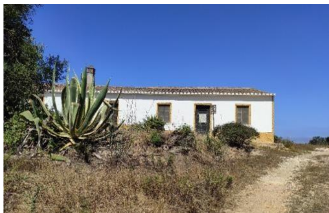
Figura 4.23 – Edifício em melhor estado de conservação no “Monte” da Endiabrada (Foto 6)
