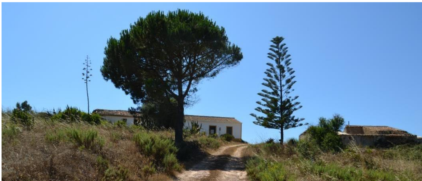
Figura 4.32 – Aldeia da Endiabrada vista de nascente
