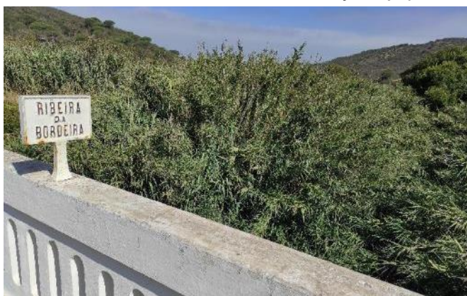
Figura 4.7 - Ribeira da Bordeira no local da ponte da N268
