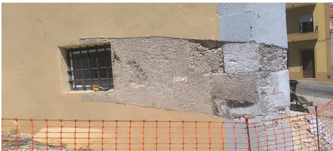
Figura 45 – Unidade [204] composta por argamassa cimentícia.
