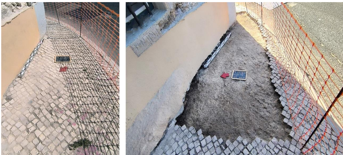
Figura 27 e 28 – Local de intervenção com a calçada [100] e camada subsequente [101].
