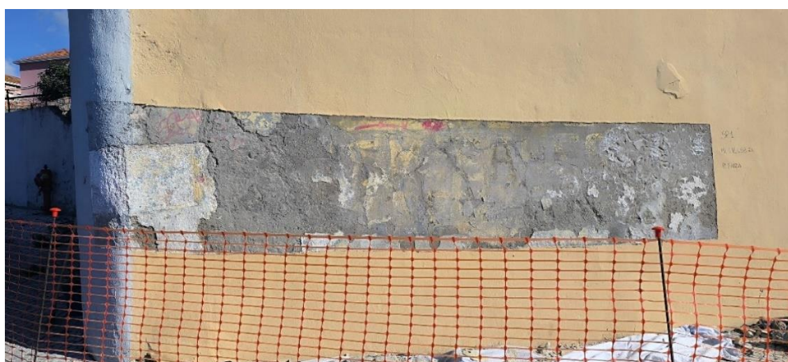
Figura 39 – SP1 após levantamento das camadas de tinta superficiais.
