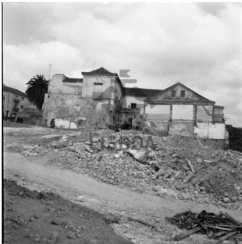
Figura 6 – Demolições parciais do Palácio Fiuza nos anos 60 do século XX (AML).
