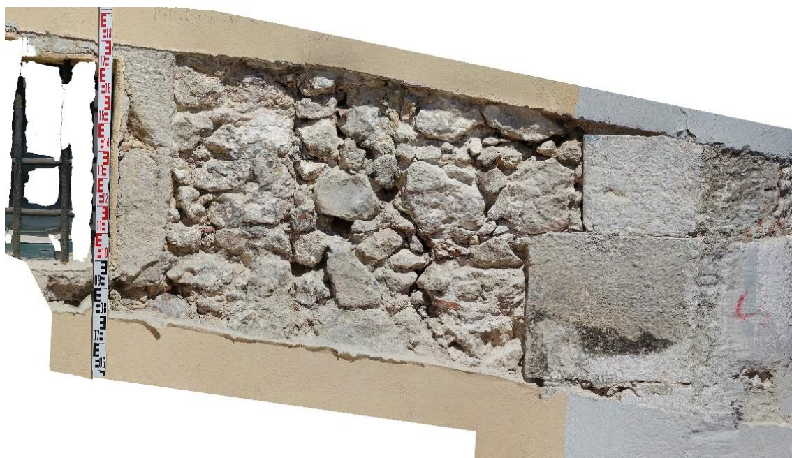
Figura 47 – Fotogrametria do plano final da SP2 com o aparelho construtivo, [208], a descoberto
