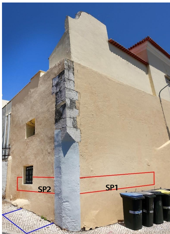
Figura 37 – Disposição das sondagens parietais, a vermelho, e da sondagem arqueológica, a azul, junto do cunhal sul do edifício.
