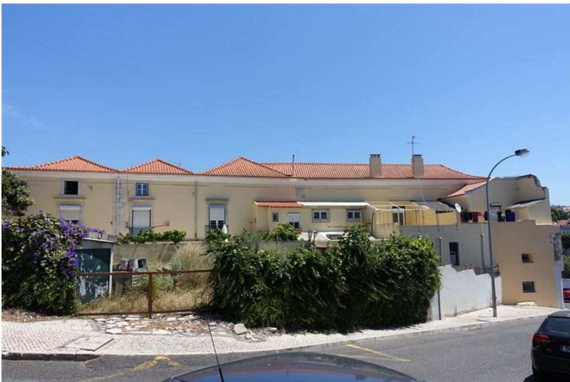
Figura 11 – Vista geral do Palácio Fiúza, à direita o corpo cuja demolição está prevista.
