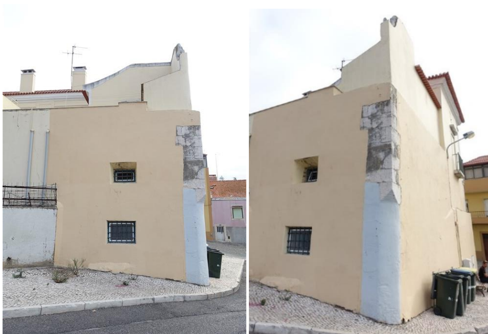
Figura 12 – Palácio Fiúza: corpo cuja demolição está prevista.
