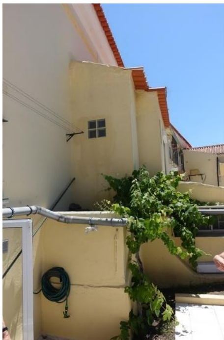
Figura 15 – Construções adossadas a noroeste cuja demolição está prevista.
