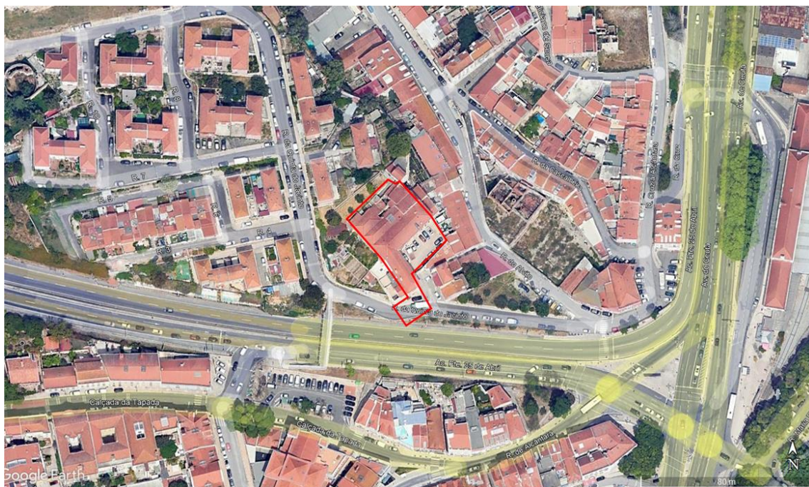
Figura 21 – Ortofoto do mesmo local na atualidade com os anteriores limites marcados a vermelho, observando a ausência do bloco sul do edifício.
