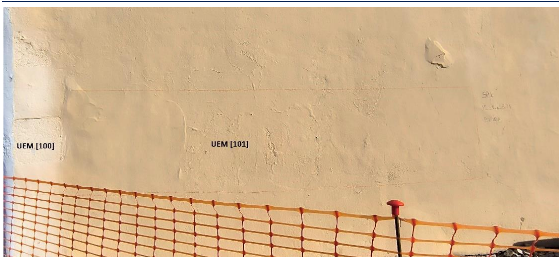
Figura 38 – Camadas de tinta superficiais na SP1.
