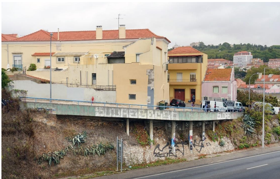
Figura 33 – Pormenor da base em viaduto da estrada que passa junto da fachada do edifício.
