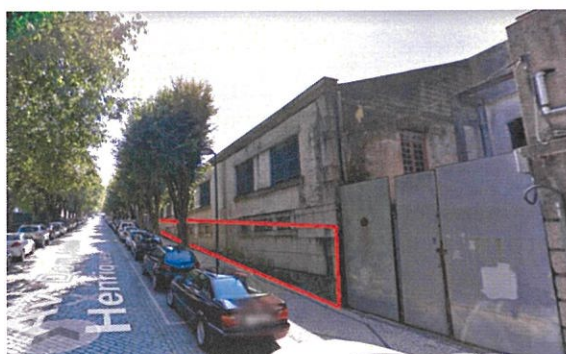
Parede a manter provisoriamente na Av. D. Afonso Henriques
