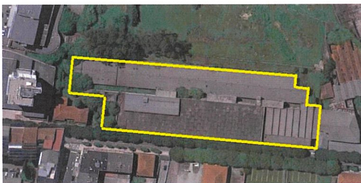
Antiga Fábrica do Cavalinho – Área de demolição
