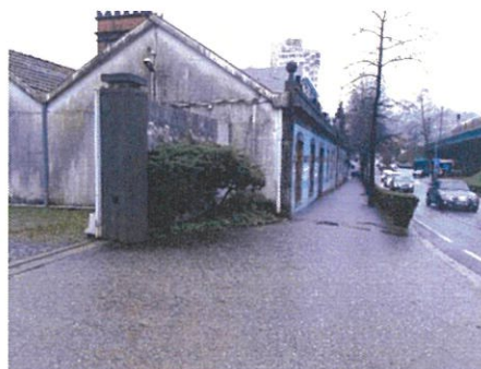
Passeio existente junto à fachada principal
