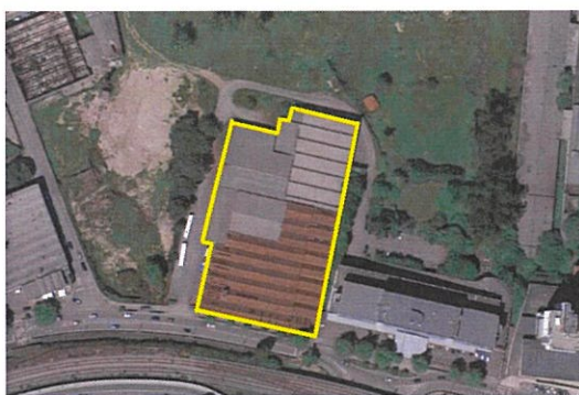
Antiga Fábrica Herculano & Pimenta – Área de demolição
