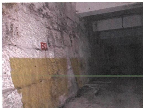
Parede de contenção a manter
