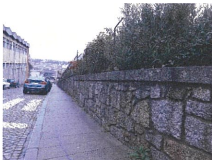
Muro de vedação a manter provisoriamente
