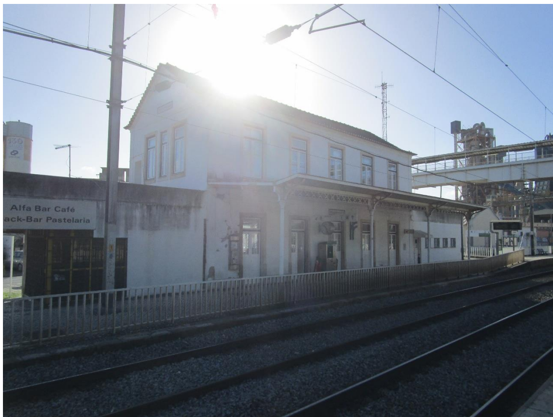
Fotografia 15 - Vista geral do edifício (NO – SE)
