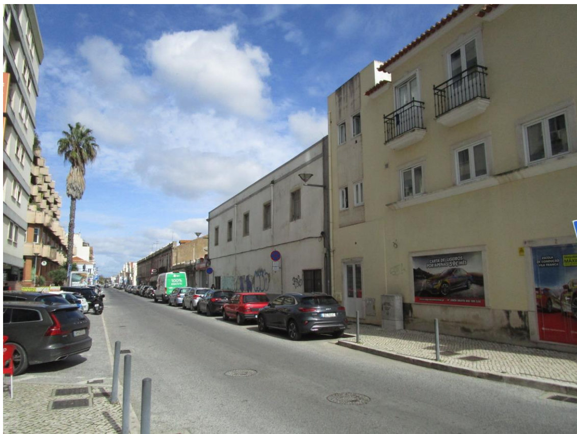
Fotografia 81 - Vista geral do edifício (SO – NE)
