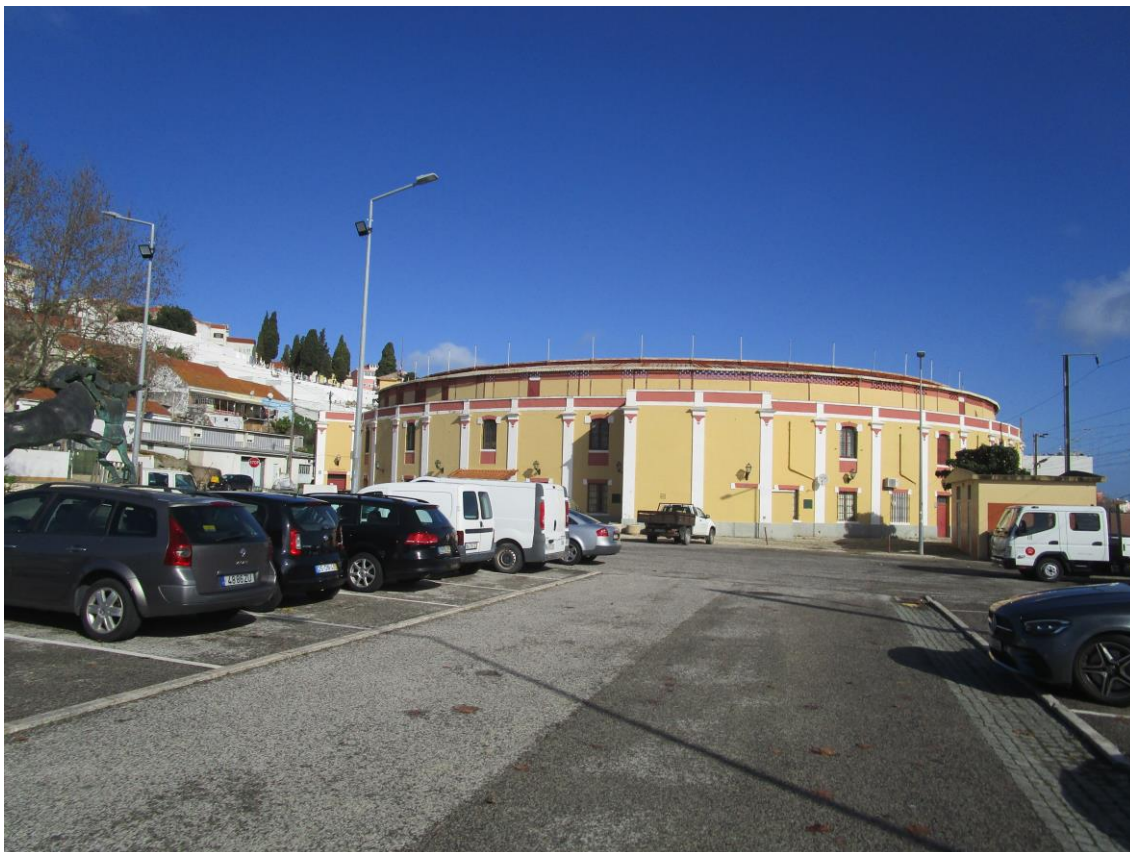
Fotografia 33 - Vista geral do edifício (SO – NE)
