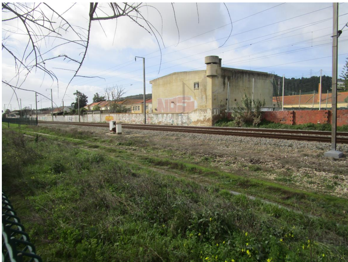
Fotografia 54 - Vista geral do edificado (NE – SO)
