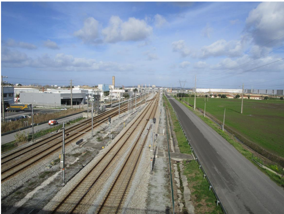
Fotografia 72 - Vista geral do terreno (SO – NE)
