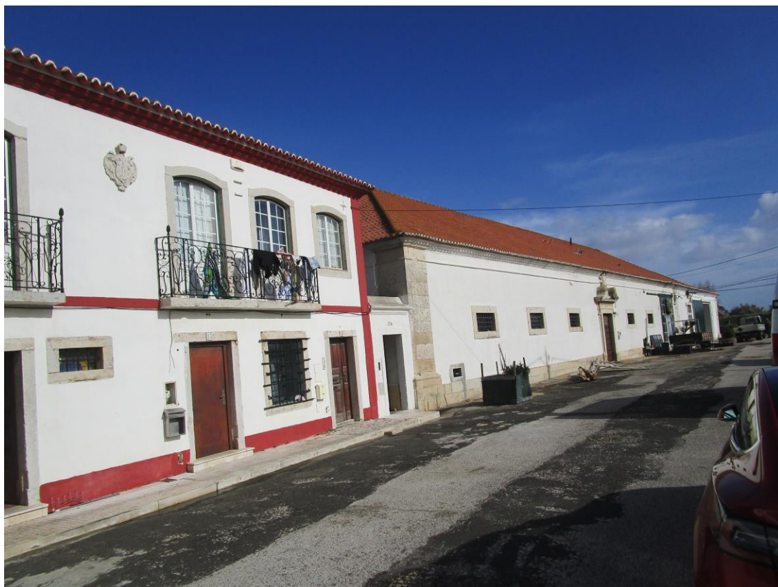
Fotografia 60 - Vista geral do edifício (NO – SE)
