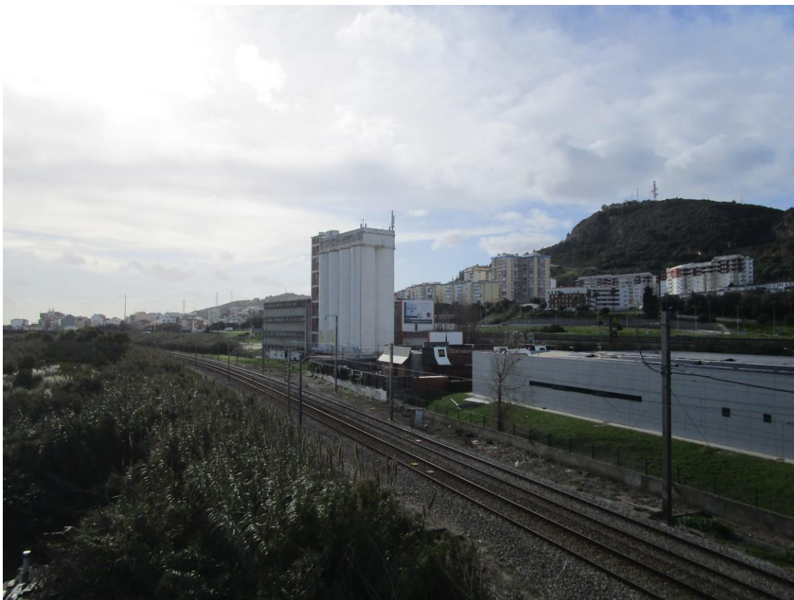
Fotografia 63 - Vista geral do edificado (NE – SO)
