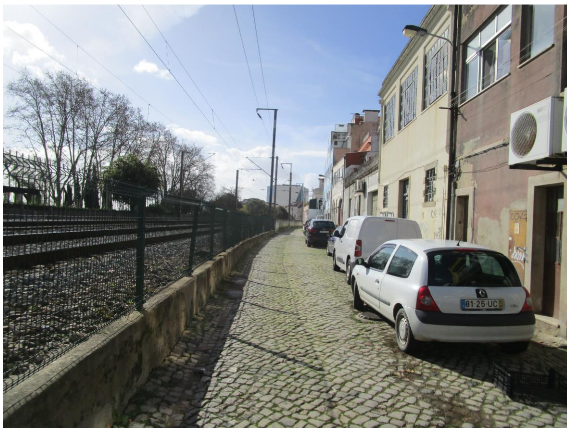
Fotografia 51 - Vista geral do edificado (NE – SO)
