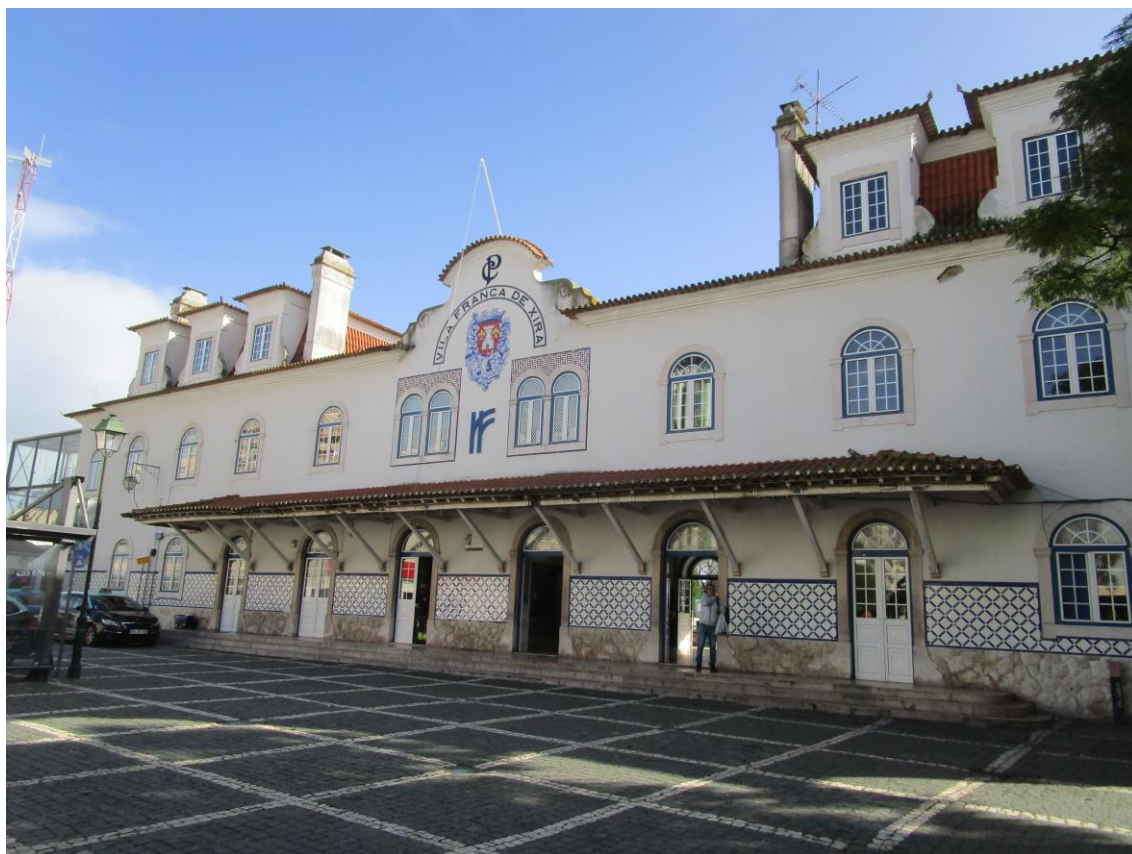
Fotografia 50 - Vista geral do edifício (SO – NE)
