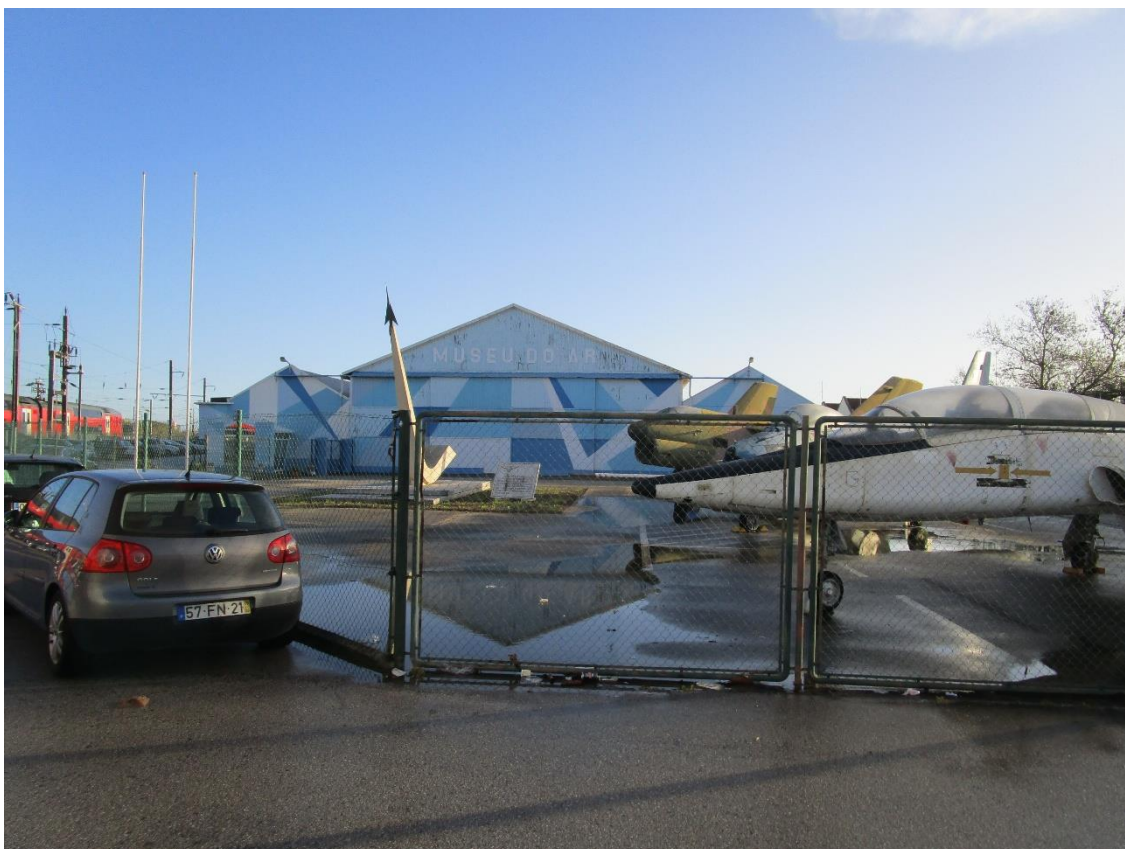
Fotografia 4 - Vista geral do terreno (SO – NE)
