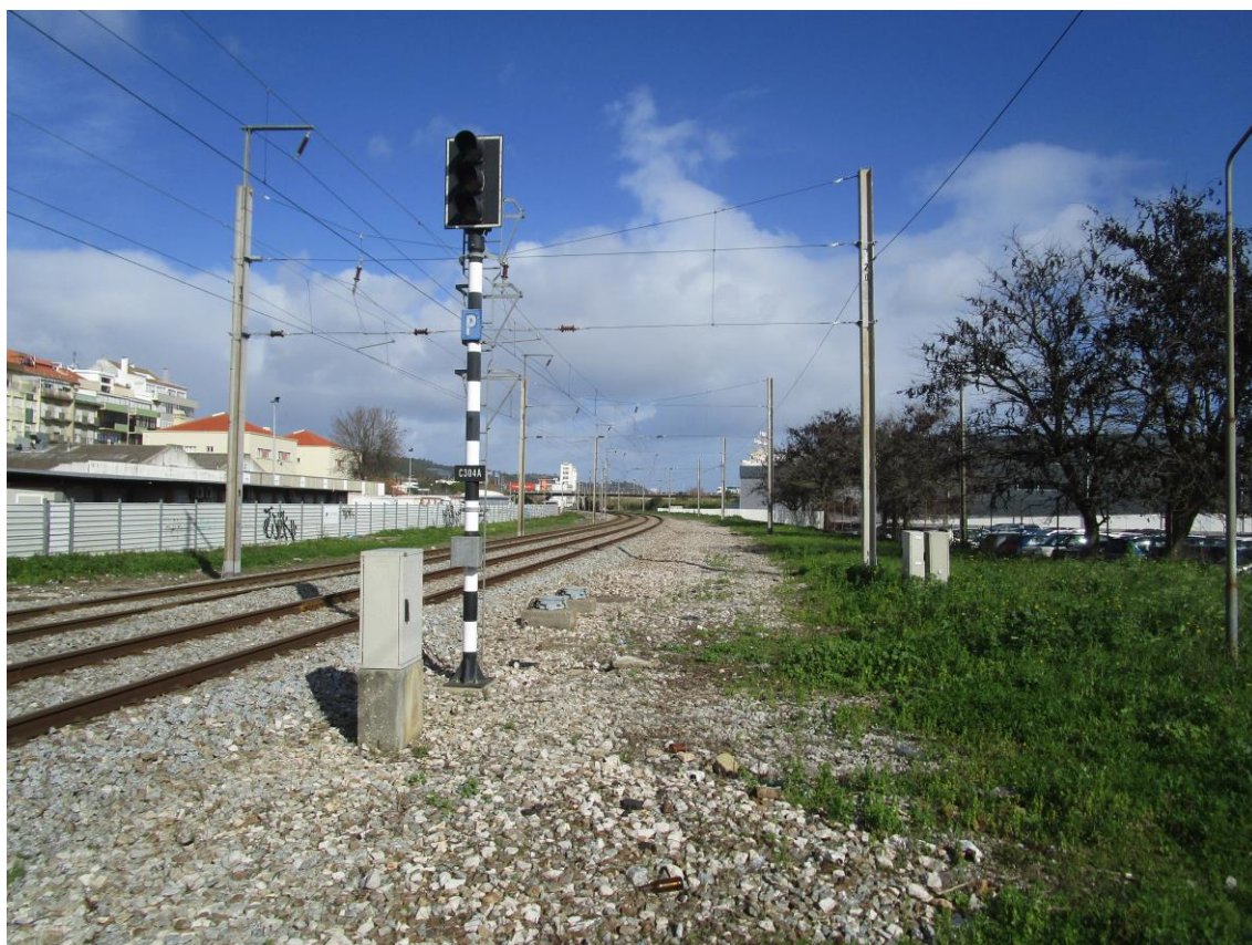
Fotografia 49 - Vista geral do terreno (SO – NE)
