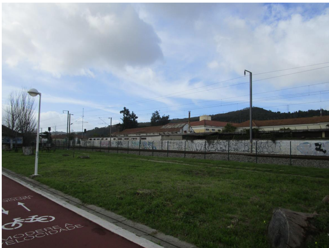
Fotografia 55 - Vista geral do edificado (NE – SO)
