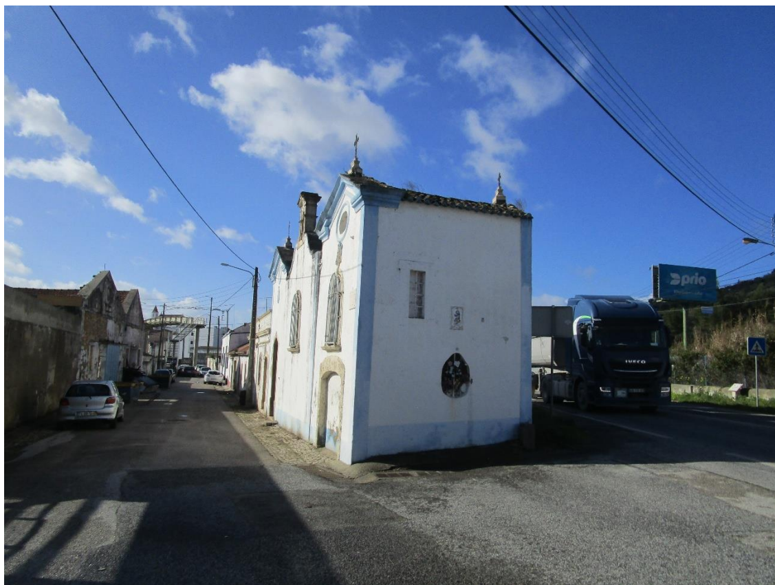
Fotografia 29 - Vista geral do edifício (SE – NO)
