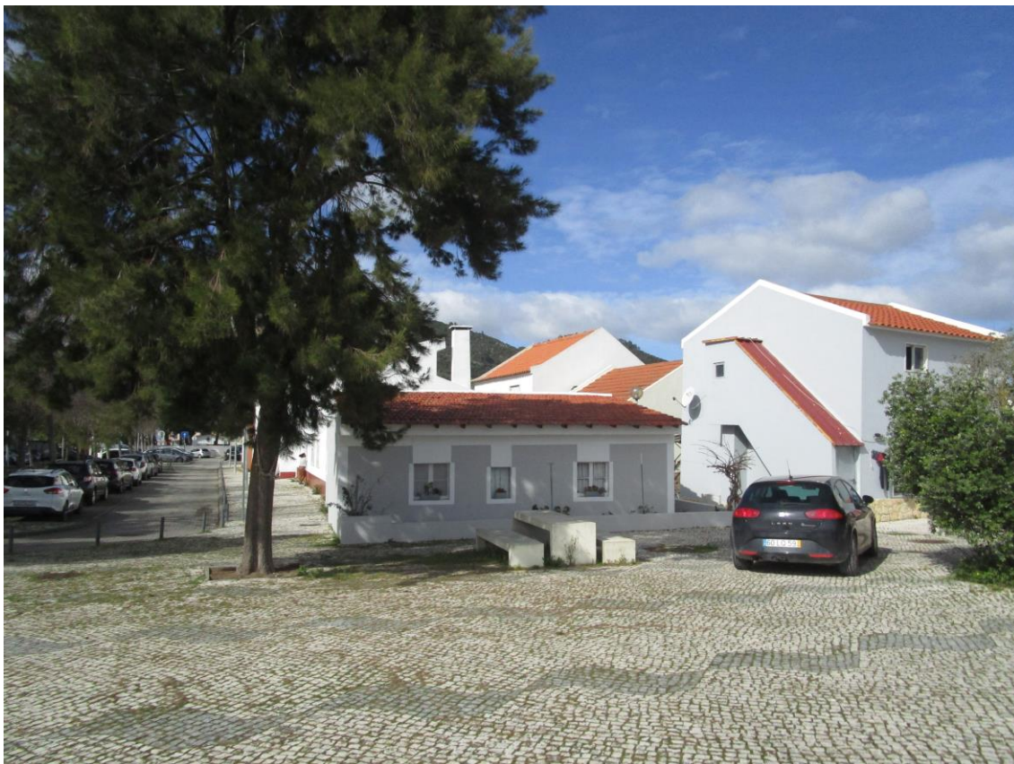
Fotografia 78 - Vista geral do edifício (SE – NO)
