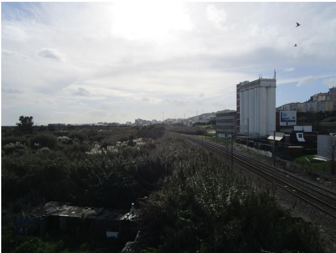
Fotografia 62 - Vista geral do edificado (NE – SO)
