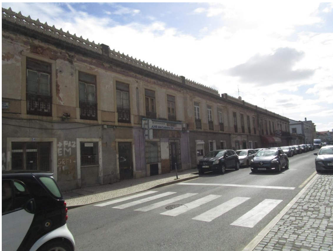
Fotografia 83 - Vista geral do edifício (N – S)
