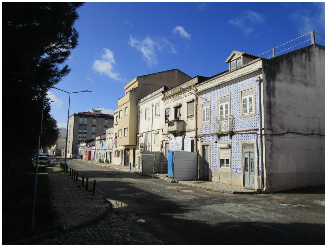
Fotografia 26 - Vista geral do edificado (NE – SO)
