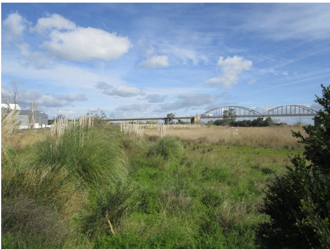
Fotografia 75 - Vista geral do local de implantação do silo (SO – NE)
