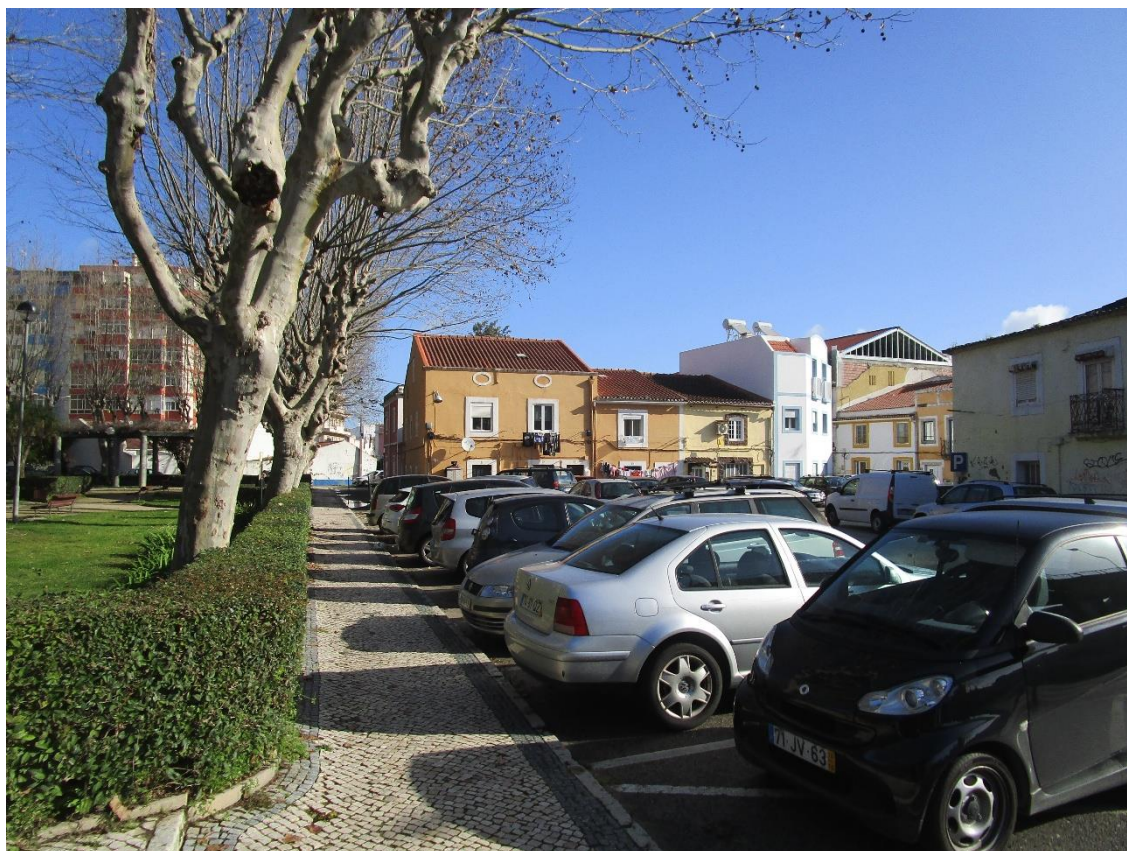
Fotografia 20 - Vista geral do edifício (SO – NE)
