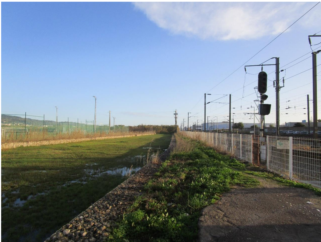
Fotografia 1 - Vista geral do terreno (SO – NE)
