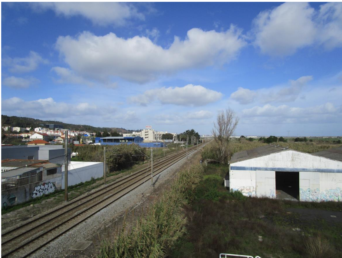
Fotografia 64 - Vista geral do terreno (SO – NE)
