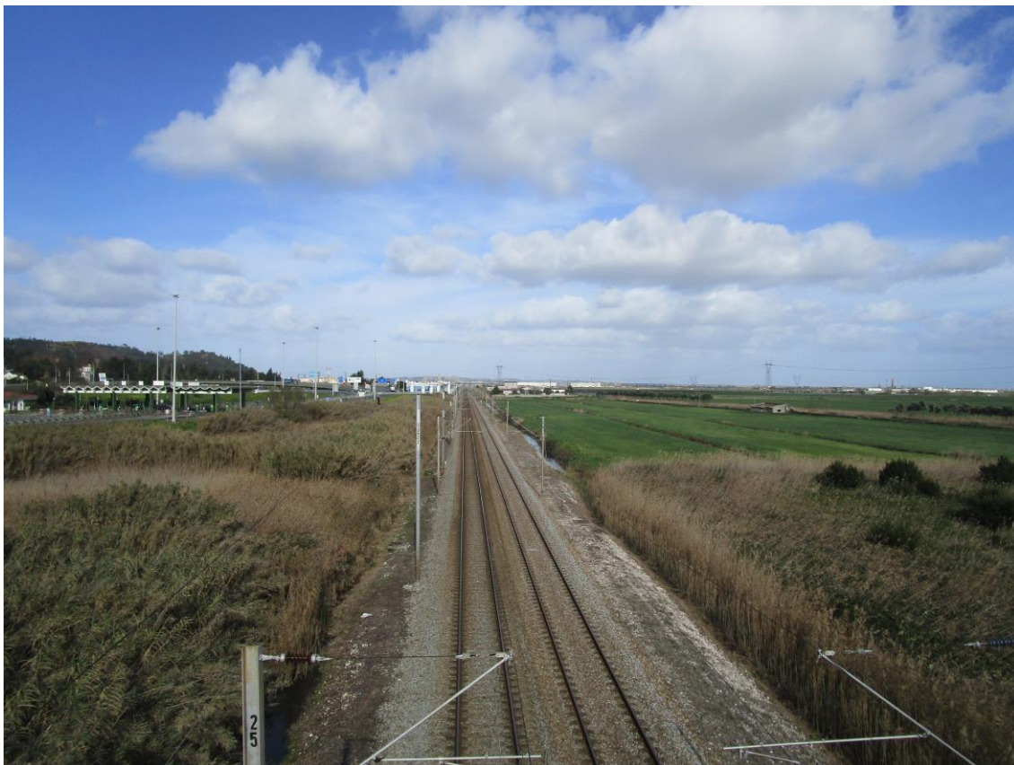
Fotografia 66 - Vista geral do terreno (SO – NE)
