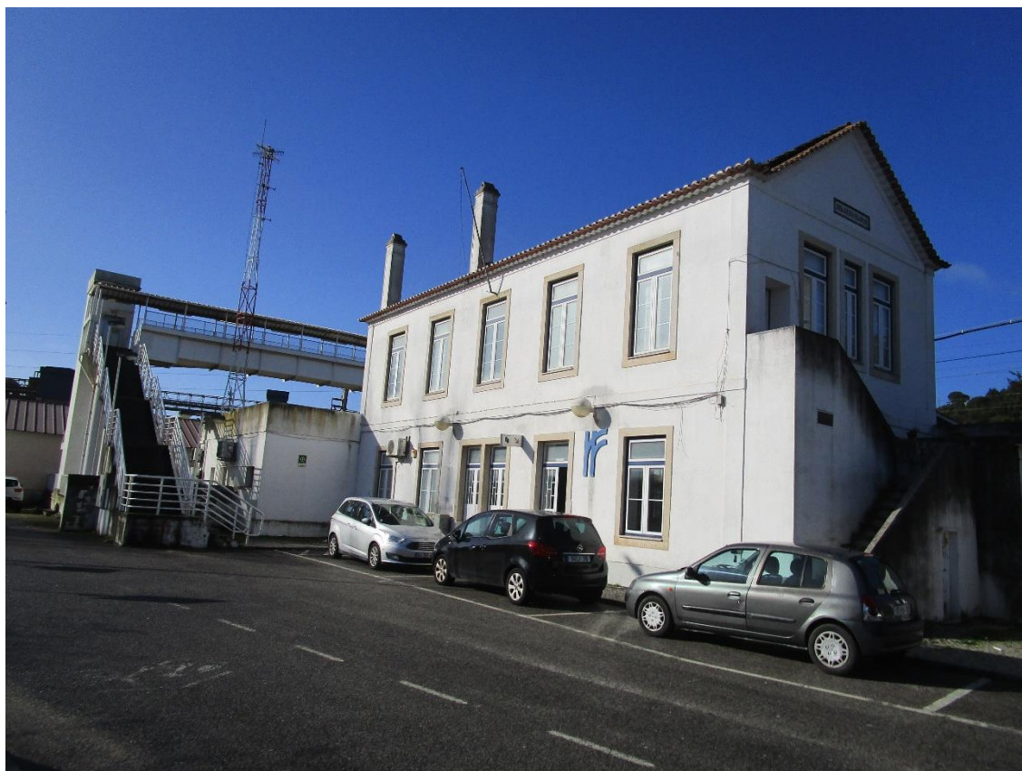
Fotografia 19 - Vista geral do edifício (NE – SO)
