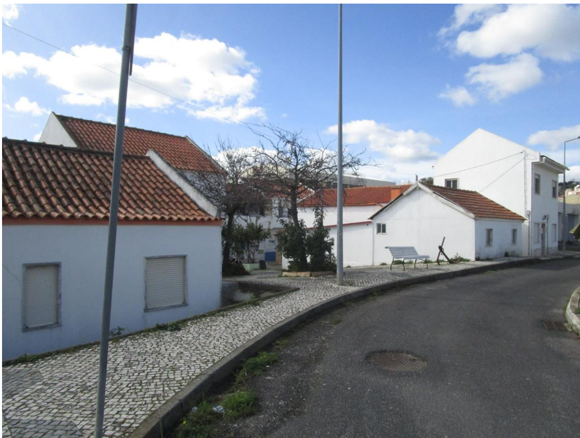
Fotografia 77 - Vista geral do edificado (NE – SO)
