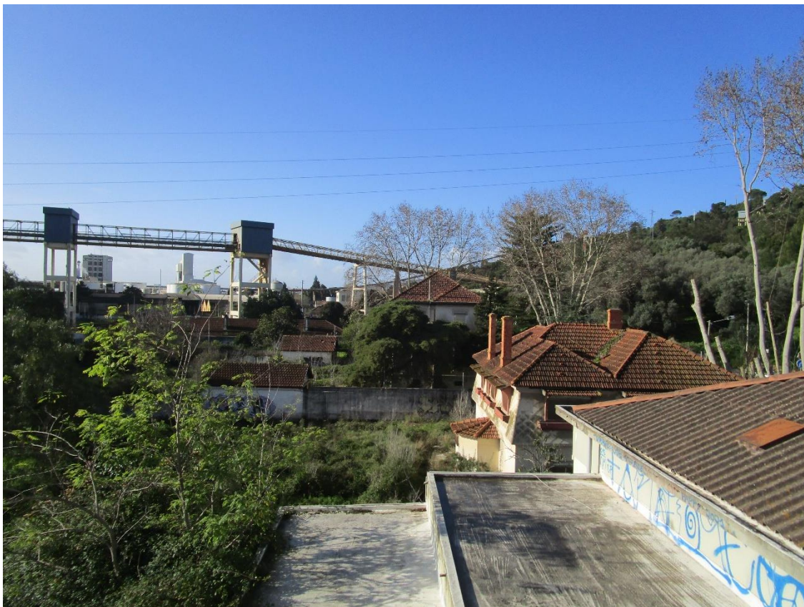
Fotografia 17 - Vista geral do edifício (NE – SO)
