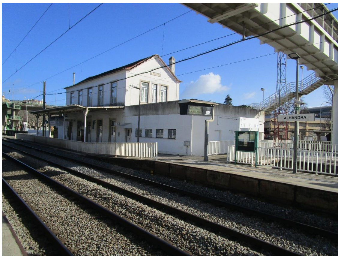
Fotografia 16 - Vista geral do edifício (SO – NE)
