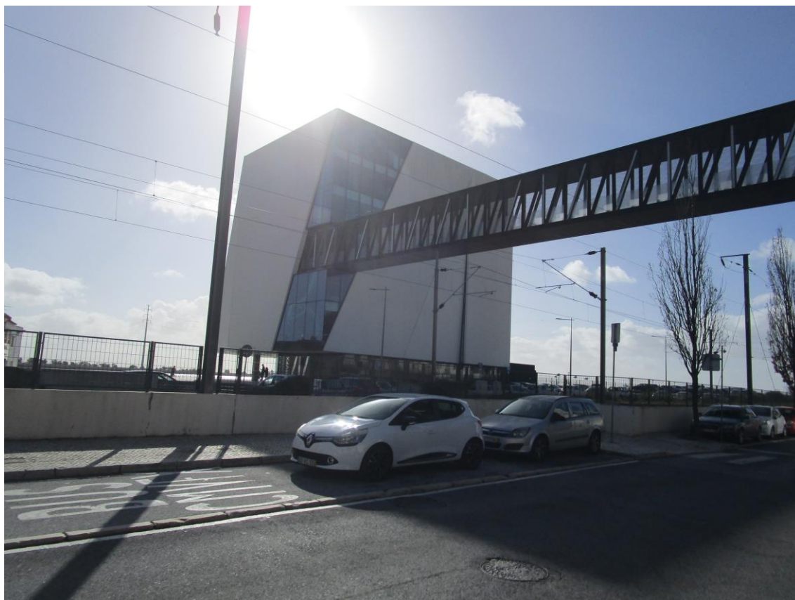
Fotografia 37 - Vista geral do edifício (N – S)
