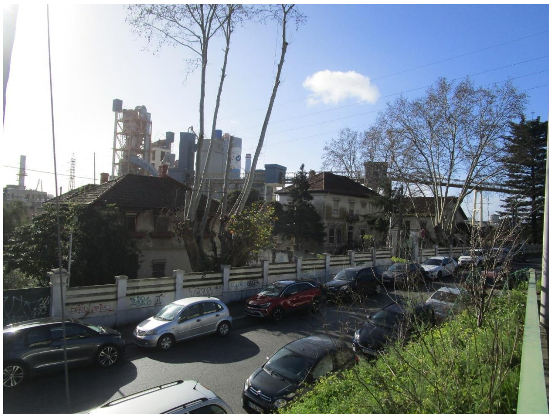
Fotografia 23 - Vista geral do edificado (NO – SE)
