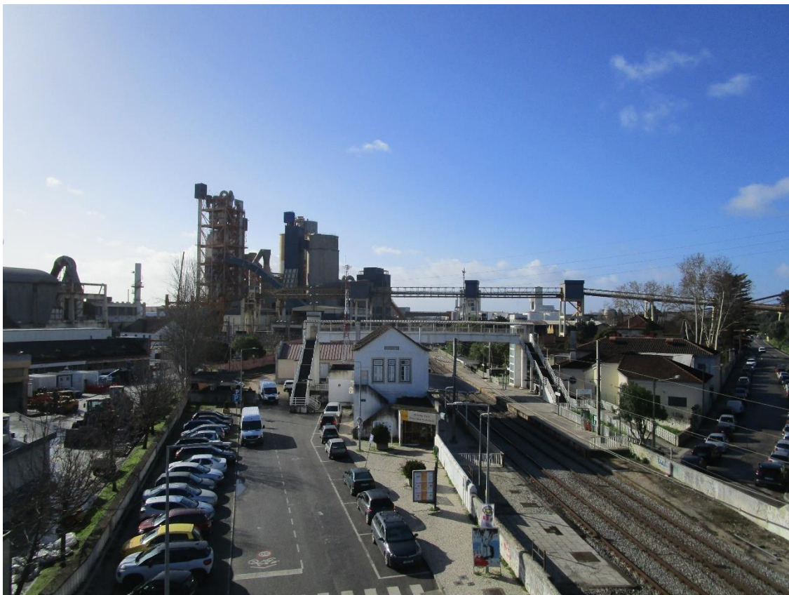
Fotografia 21 - Vista geral do edifício (N – S)
