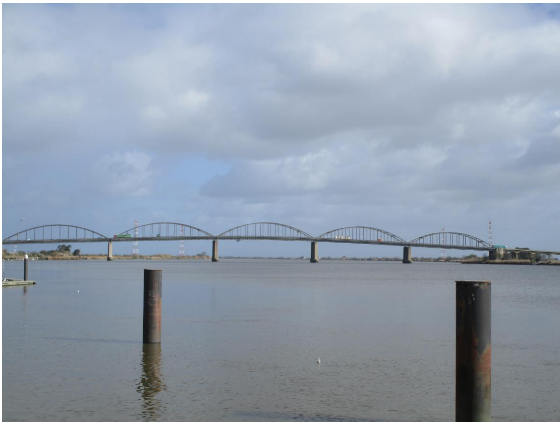
Fotografia 52 - Vista geral da ponte (S – N)
