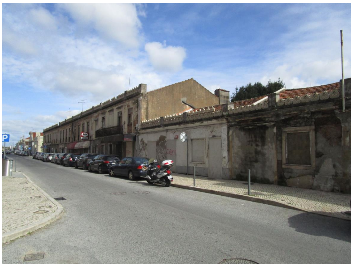
Fotografia 82 - Vista geral do edifício (SO – NE)
