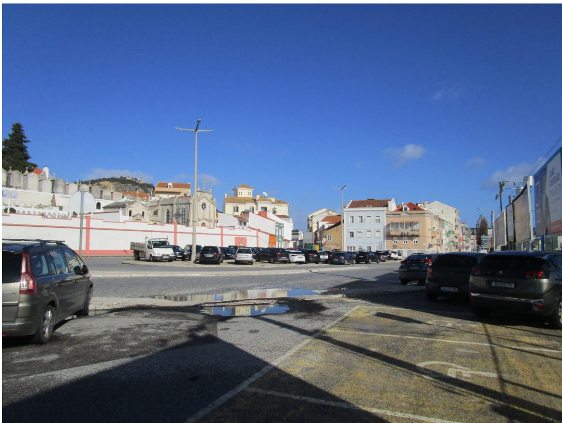
Fotografia 34 - Vista geral do edifício (S – N)
