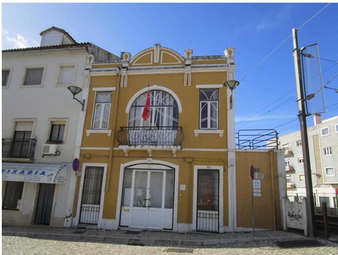
Fotografia 38 - Vista geral do edifício (NE – SO)
