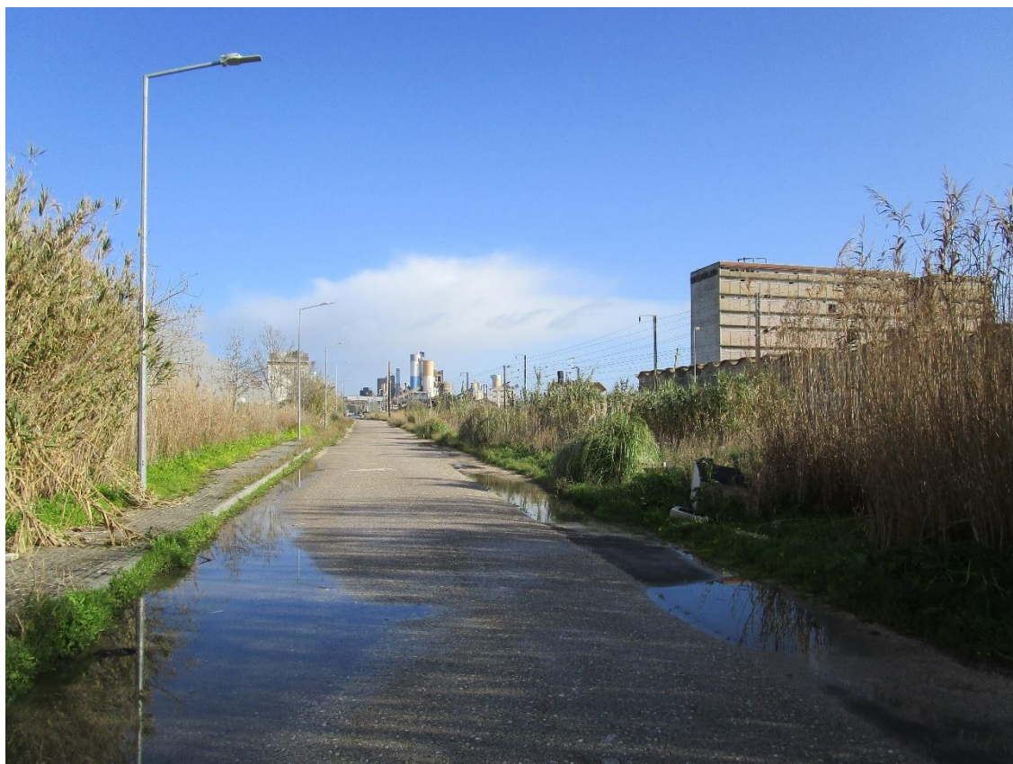
Fotografia 13 - Vista geral do terreno (SO – NE)
