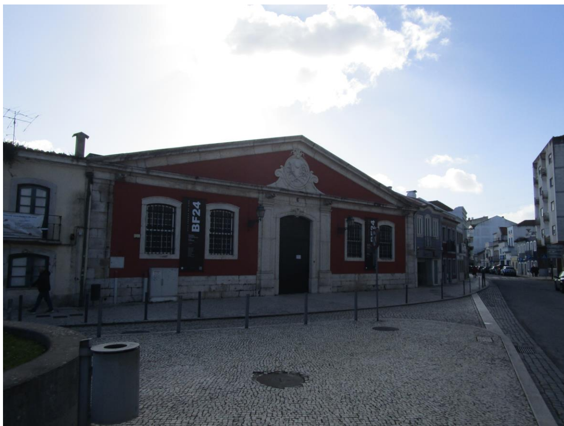
Fotografia 36 - Vista geral do edificado (NO – SE)
