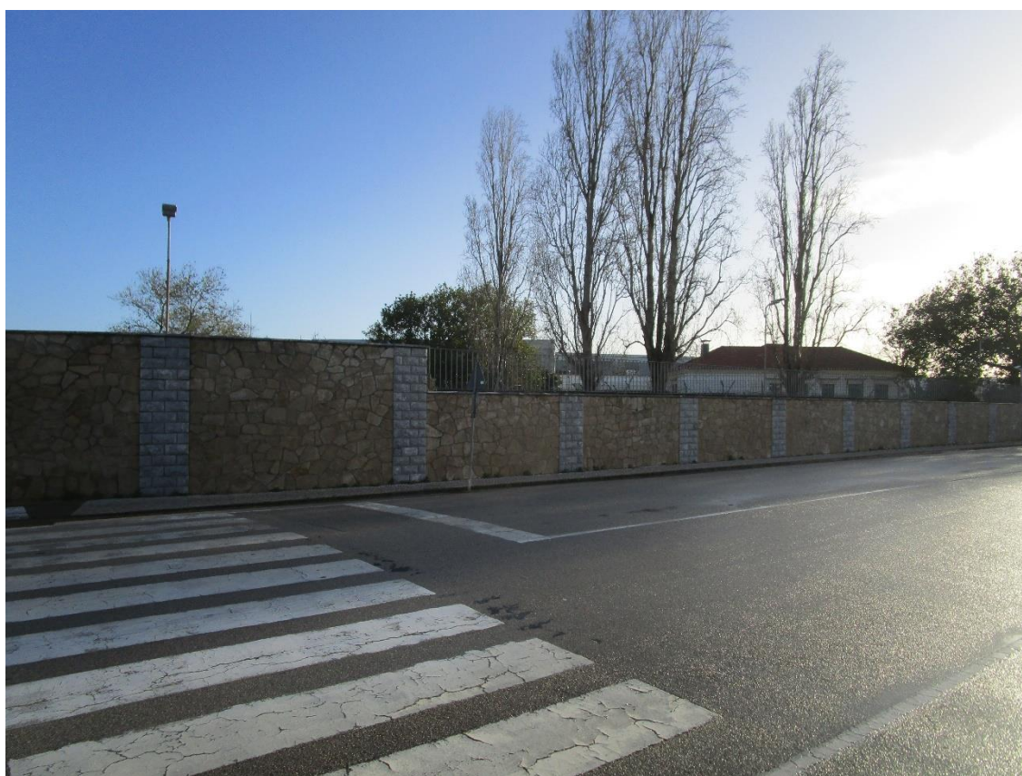
Fotografia 6 - Vista geral do terreno (SO – NE)
