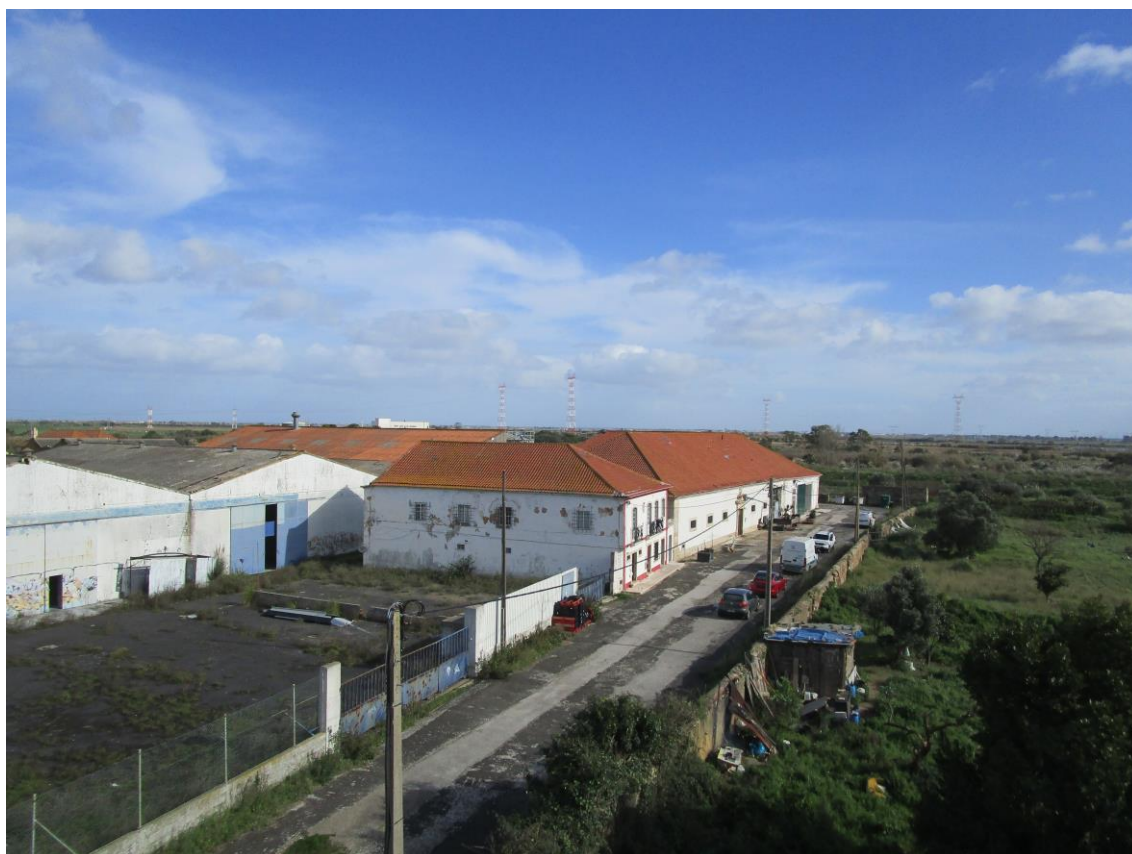
Fotografia 61 - Vista geral do edifício (O – E)
