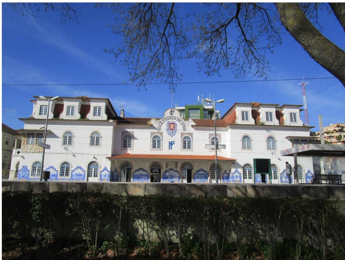
Fotografia 48 - Vista geral do edifício (SE – NO)
