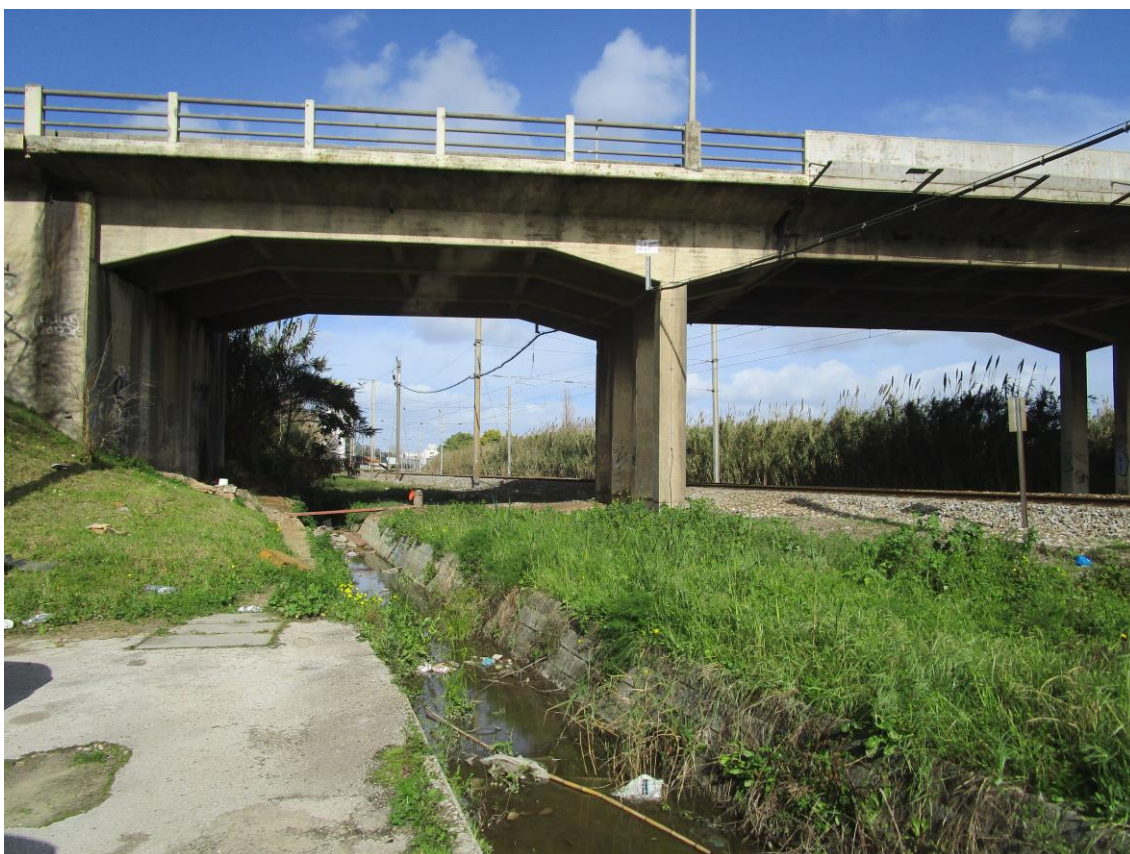
Fotografia 59 - Vista geral do terreno (SO – NE)
