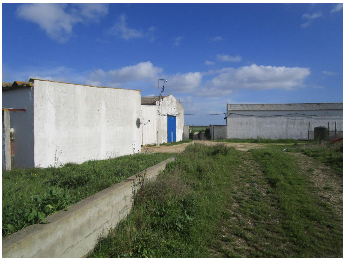
Fotografia 69 - Vista geral do edificado (NO – SE)
