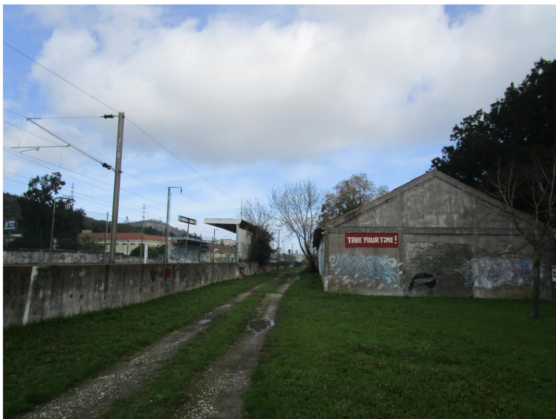
Fotografia 57 - Vista geral do terreno (SO – NE)
