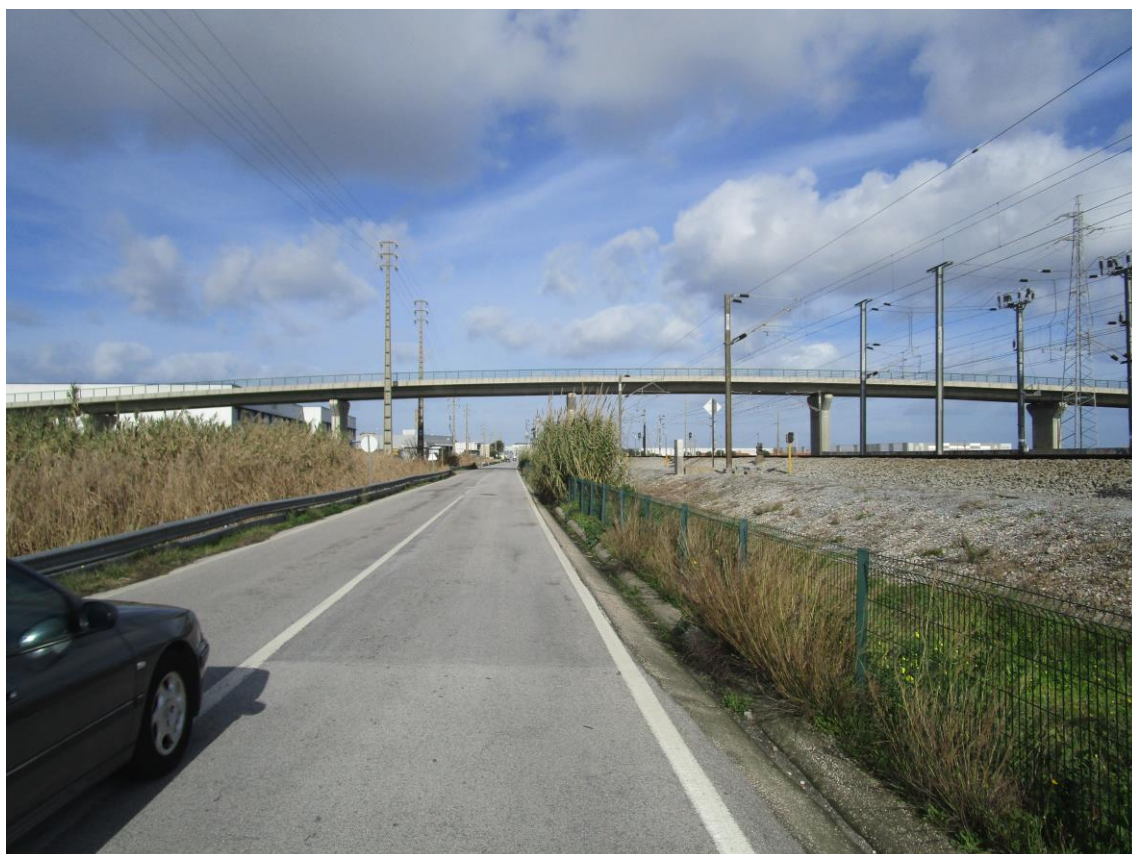
Fotografia 71 - Vista geral do terreno (SO – NE)
