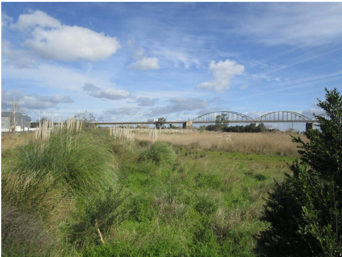
Fotografia 74 - Vista geral do local de implantação do silo (SO – NE)
