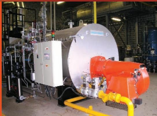
La caldera BWD de 3 pasos de humos y cámara de retorno de gases inundada abierta sin tirantes, es una caldera de alto rendimiento de construcción específica BABCOCK WANSON.
