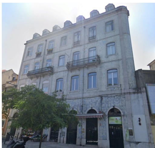
Figura 2 – Edifício na Rua da Costa a reconstruir, interferência N° 388 (Google Earth)
