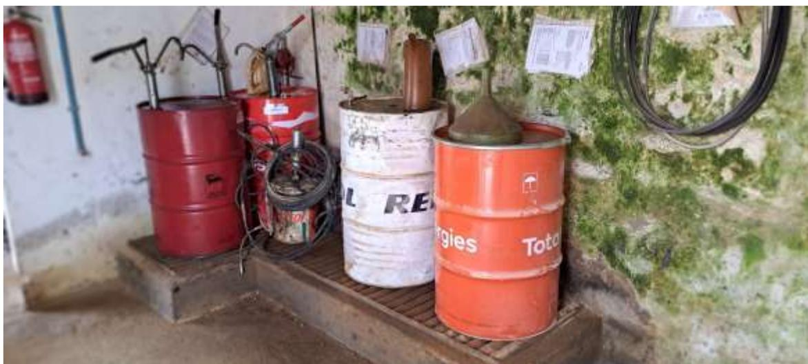
Figura 8 - Bacias de contenção de armazenamento de lubrificantes na pedreira vizinha.
