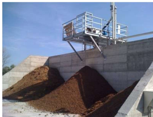
Figura 22 – Sólidos resultantes do filtro prensa
