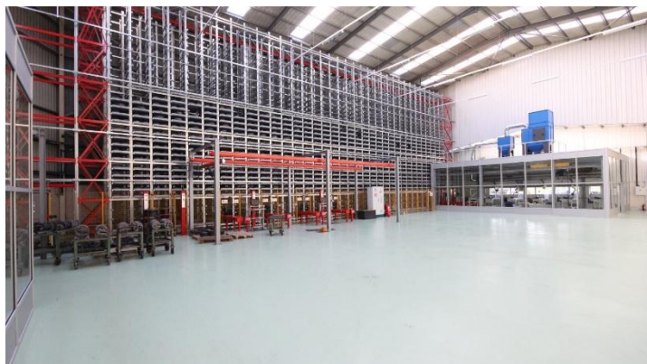
Figura 17: Novo espaço de armazenamento (espaço da antiga Lacagem Vertical I).
