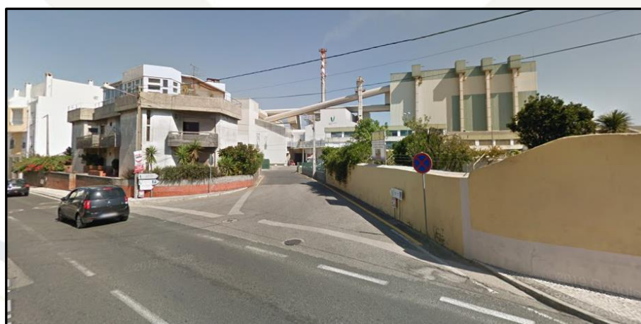
Fig. 5.40 - Vista da GALLOVIDRO a partir da via de comunicação - M242-1
