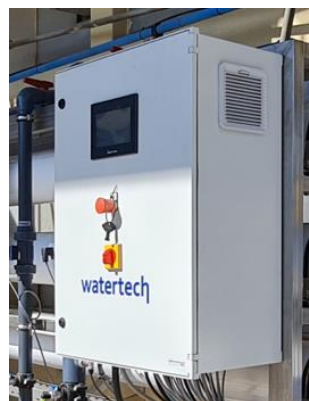
Figura 76- Representação gráfica e fotográfica do quadro elétrico com a sua consola táctil.
