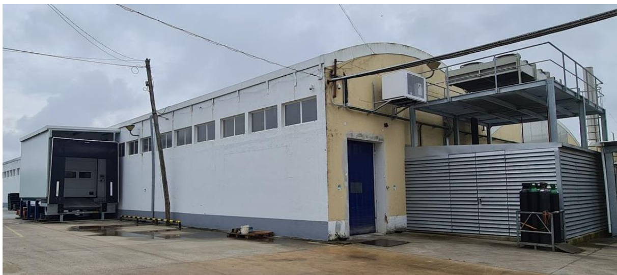
Figura 45 -Registo fotográfico da câmara frigorífica depois das alterações.
