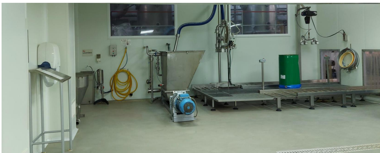
Figura 57- Registo fotográfico da sala de abertura.
