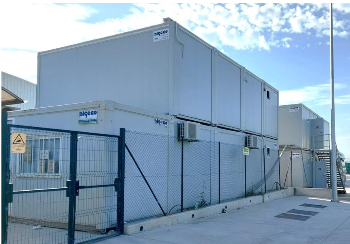
Figura 21- Registo fotográfico dos contentores pré-fabricados das instalações sanitárias
