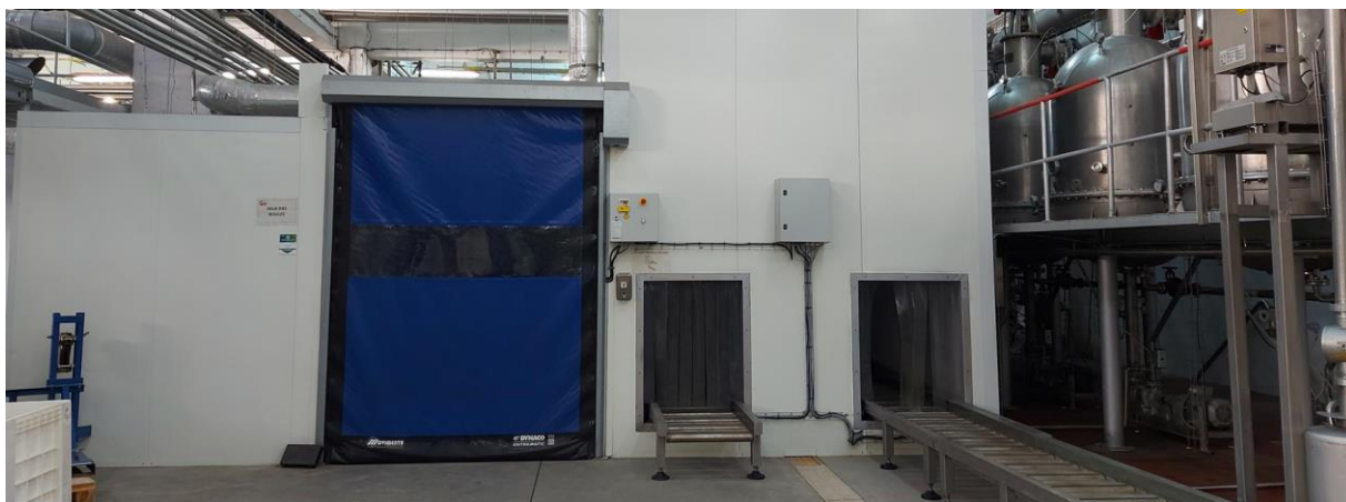
Figura 56- Registo fotográfico da entrada da sala de abertura.
