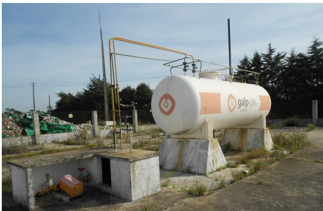
Figura 16- Registo fotográfico do depósito de armazenagem de GPL desativado.
