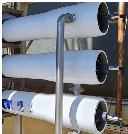
Figura 72 - Representação gráfica e fotográfica dos invólucros das membranas da unidade de osmose inversa
