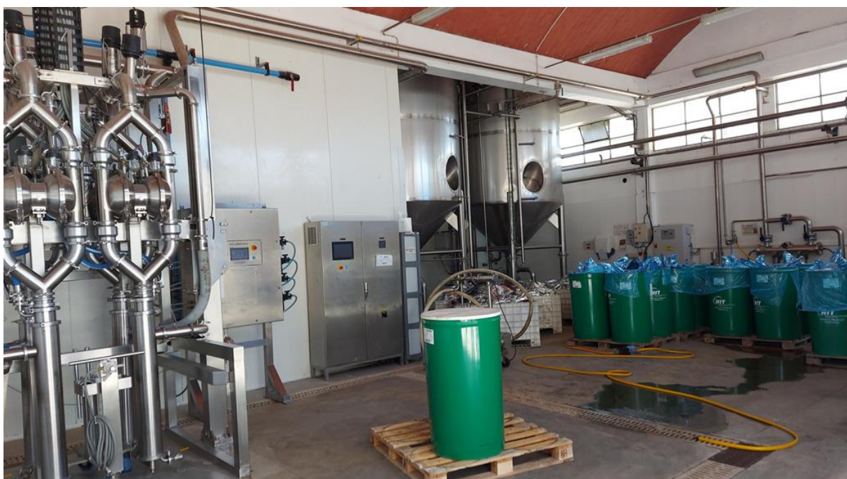
Figura 53- Registo fotográfico da sala de rework.
