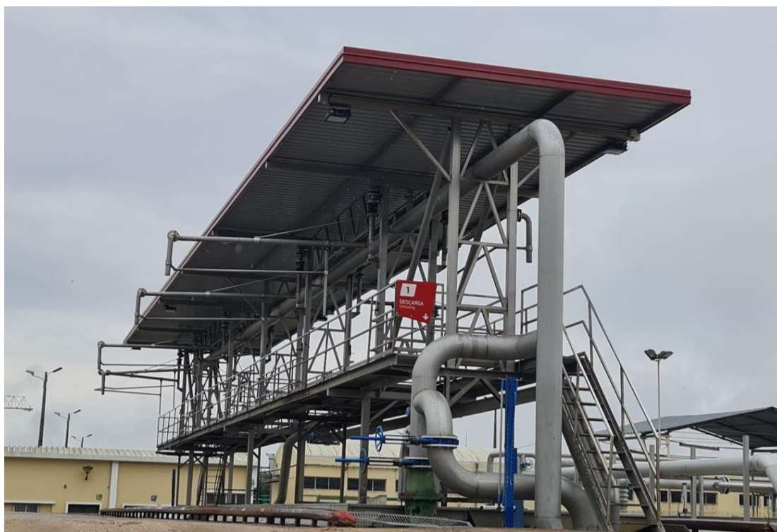
Figura 14- Registo fotográfico do telheiro instalado na zona de descarga de tomate nº1.
