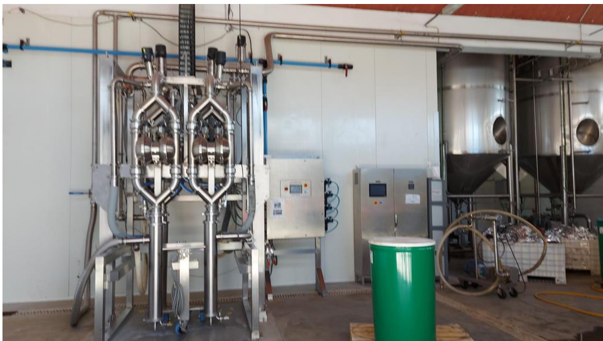
Figura 54- Registo fotográfico da sala de rework.
