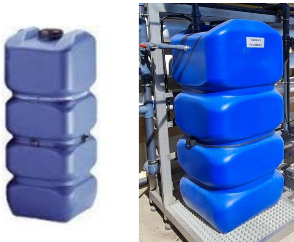
Figura 74- Representação gráfica e fotográfica do modelo de depósito vertical do circuito Flushing
