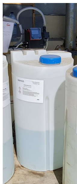
Figura 68 - Representação gráfica e fotográfica do sistema de dosagem de redutor de cloro
