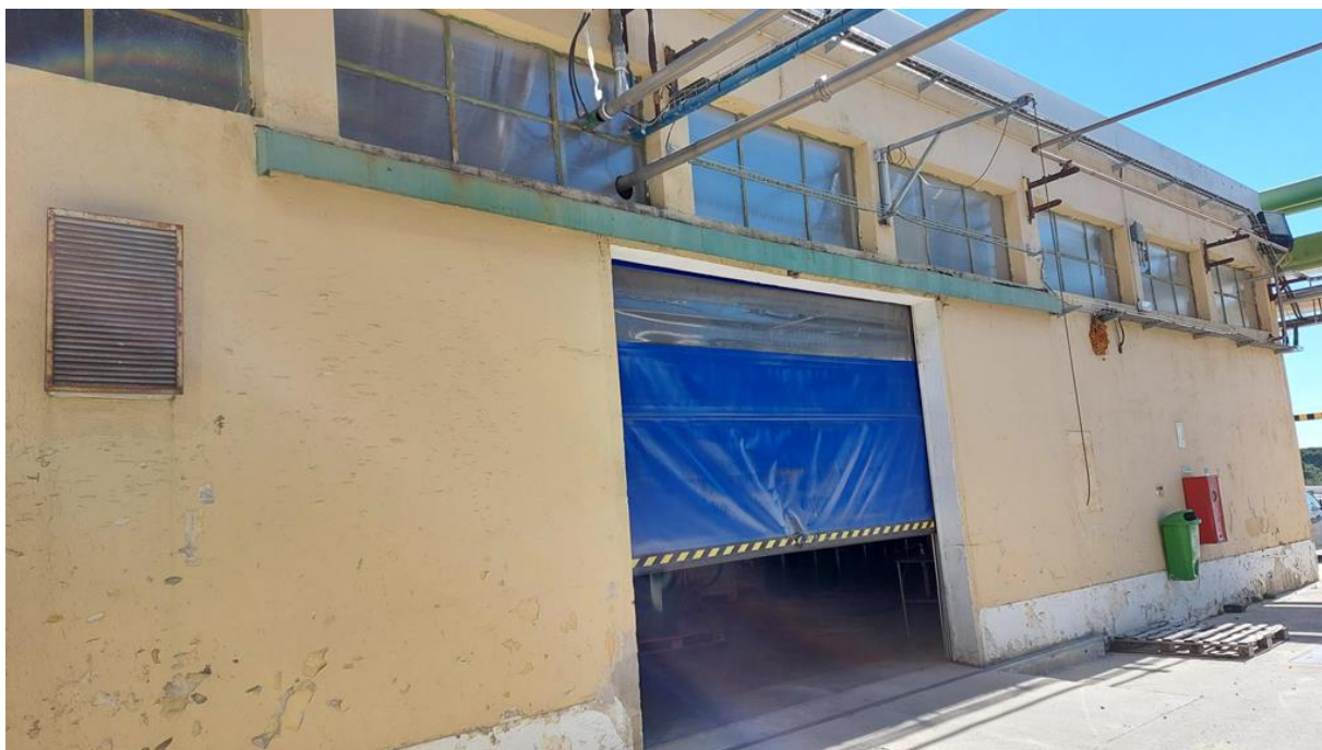
Figura 52- Registo fotográfico do edifício onde se encontra a sala de rework.
