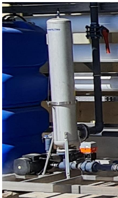
Figura 69- Representação gráfica e fotográfica da unidade de microfiltração de 5 micron
