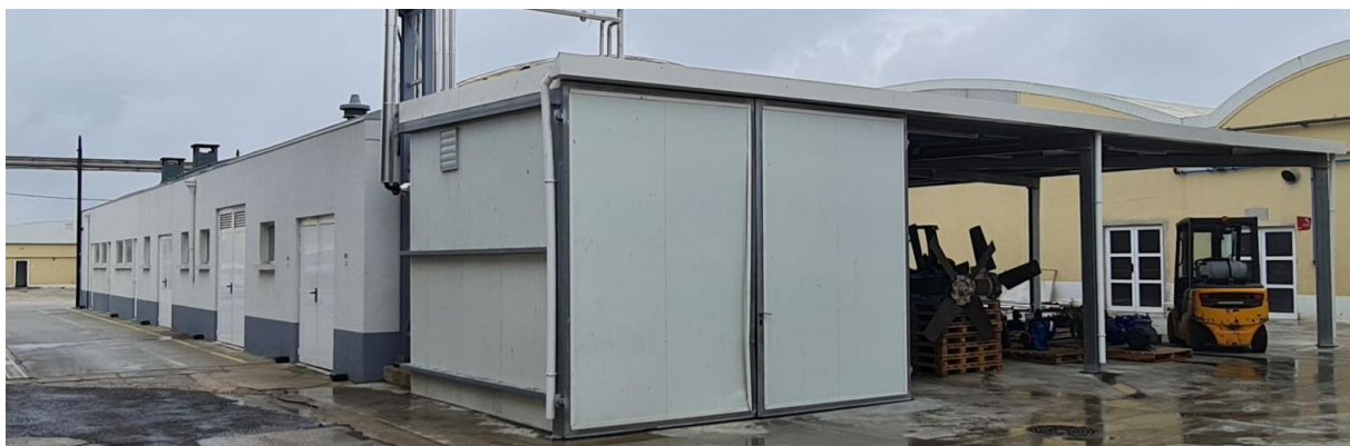
Figura 8 - Registo fotográfico do Edifício 4 após a requalificação e ampliação.
