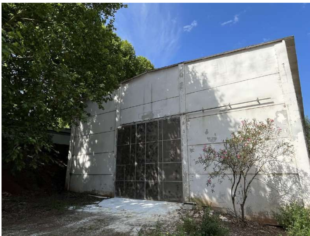
Figura 3.1.3. Pavilhão de armazenamento de estrume
