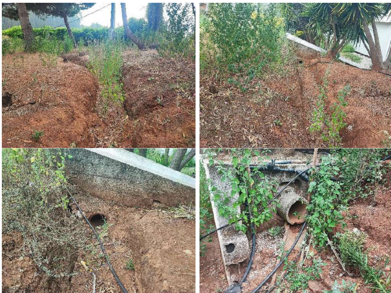
Figura 4.6.6. Vestígios da antiga existência de linha de água LA2, a montante do Pavilhão 1
