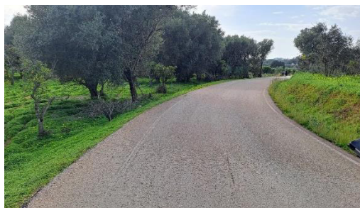
Fotografia 4-5 - Caminho da Roupeira: passagem da vala dupla no lado esquerdo, traçado comum aos Circuitos de Compressão de Água Bruta e de Descarga da Salmoura
