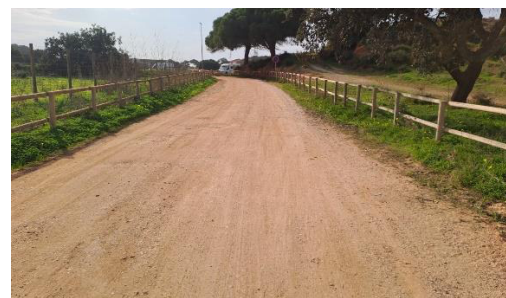
Fotografia 4-8 – Estrada da Rocha Baixinha, já perto da EE1, onde tem início o Circuito de Compressão de Água Bruta
