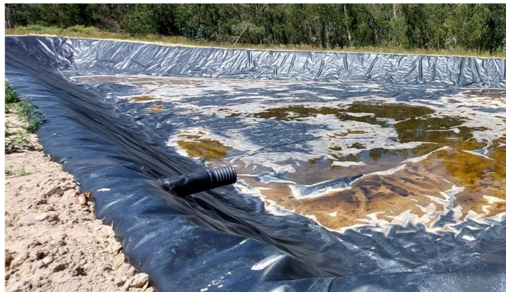
Foto 15 – Impermeabilização lagoa nº5
