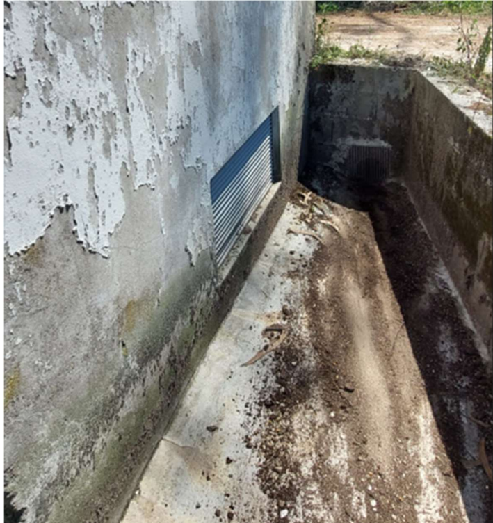
Foto 8 – Grelha de escoamento traseira
