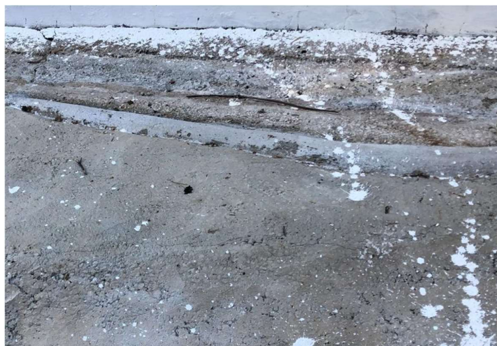
Foto 6 – Sistema de recolha de lixiviados
