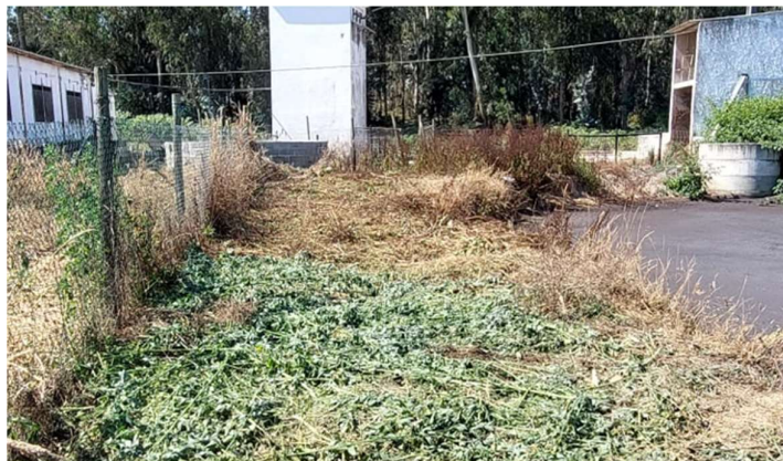
Foto 16 – Colocação de vedação da 1ª lagoa
