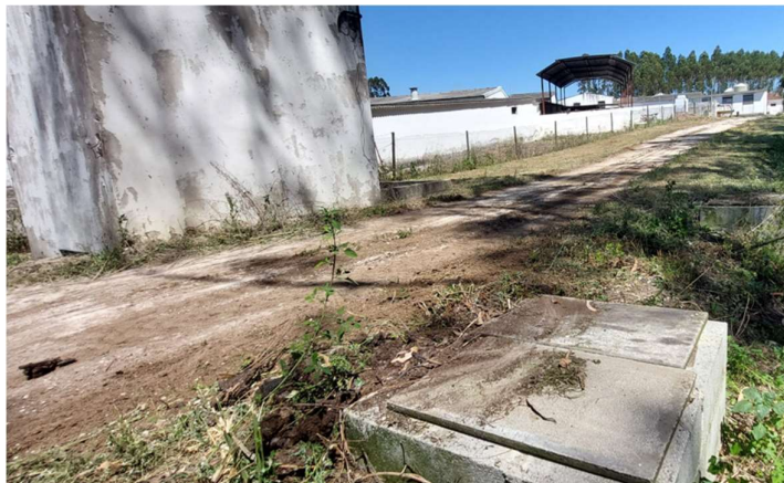
Foto 9 – Caixa de encaminhamento das águas
