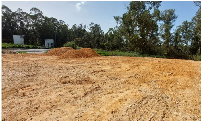
Foto 17 – Limpeza e remoção de resíduos junto à 1ª lagoa
