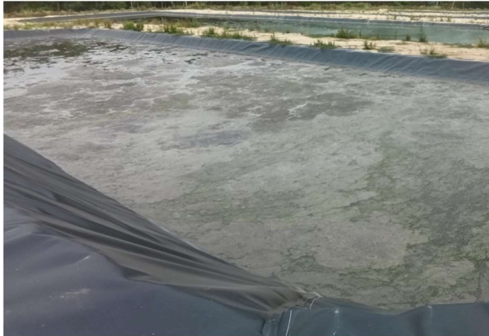
Foto 12 – Impermeabilização lagoa n°2
