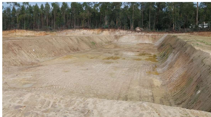
Foto 10 – Construção das novas lagoas
