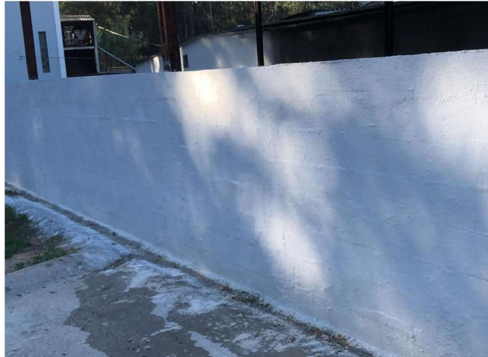
Foto 5 – Impermeabilização da nitreira (armazém de tamisados)
