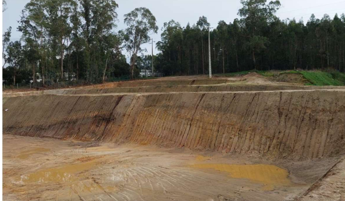
Foto 11 – Construção das novas lagoas
