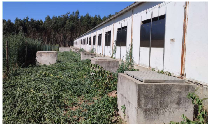
Foto 4 – Tamponamento das caixas de drenagem
