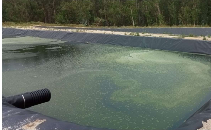
Foto 14 – Impermeabilização lagoa nº4
