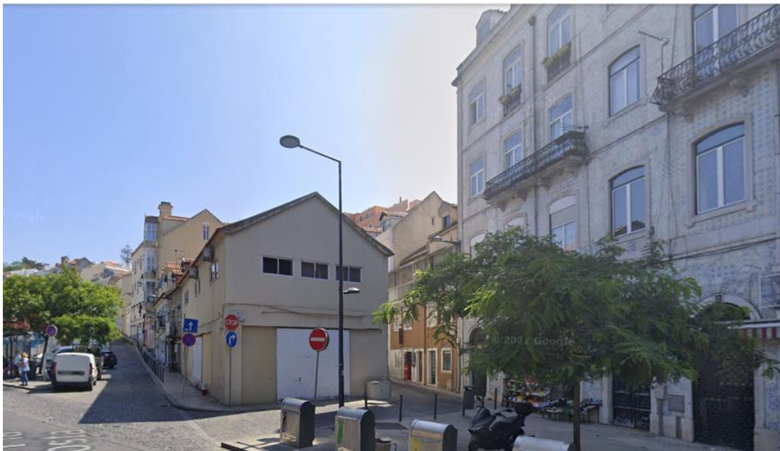
Foto 1 – Vista envolvente e SW do edifício vistoriado
