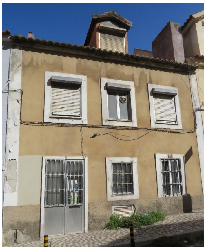
Foto 2 – Fachada posterior a nascente
