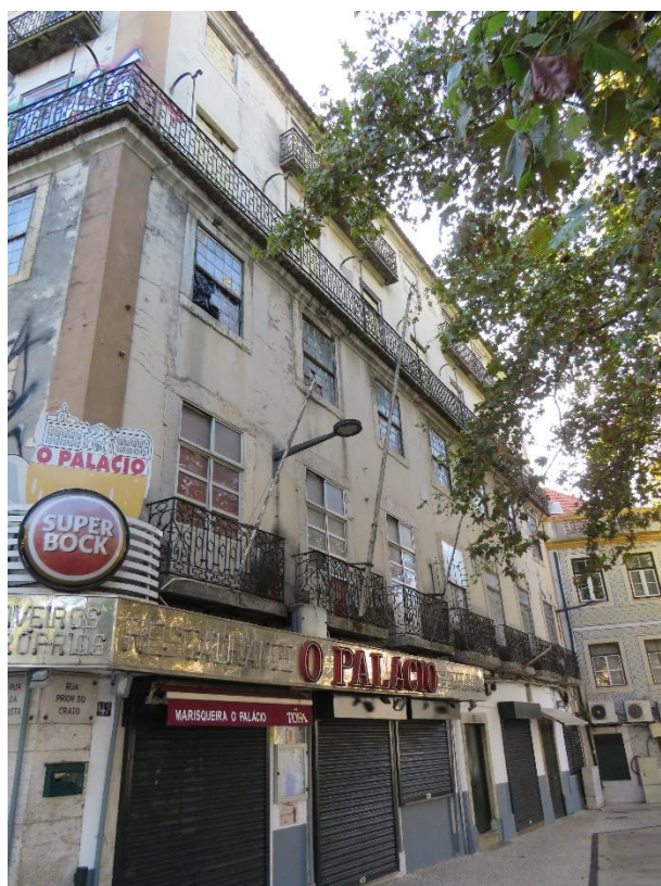
Foto 2 – Fachada sul do edifício
