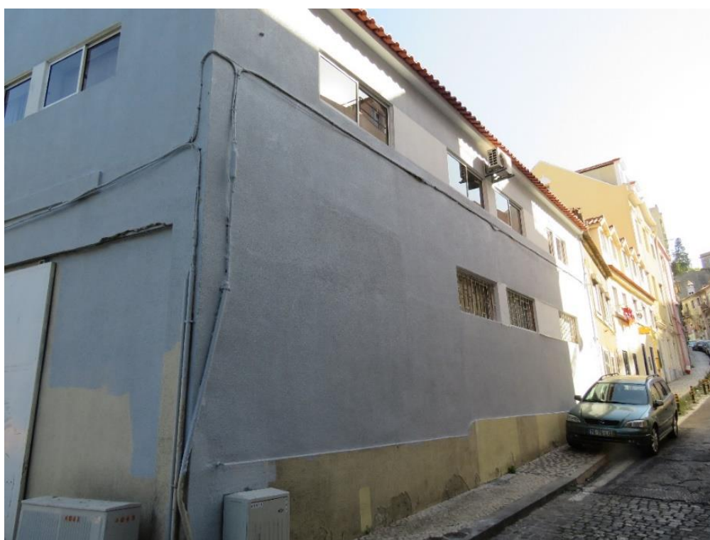
Foto 2 – Fachada posterior nascente do edifício
