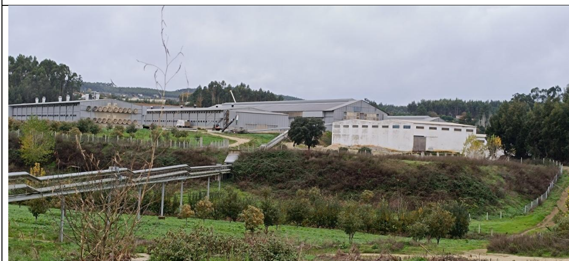
Figura 7.30 – Vistas de outras áreas de usos industriais (instalação avícola da Cabrala) localizados na proximidade da instalação avícola em estudo.
