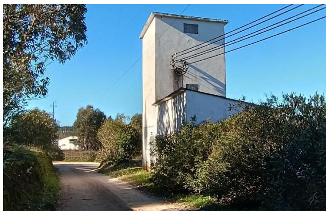
Figura 0.3 – Vista para o Posto de Transformação
