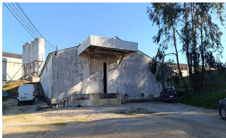
Figura 0.2 – Vista para o ARO1
