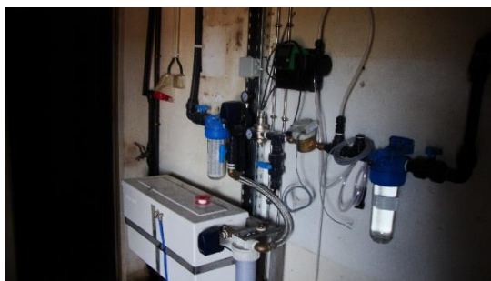
Fig. 1 – exemplo de Kit de abastecimento à entrada de cada aviário;
