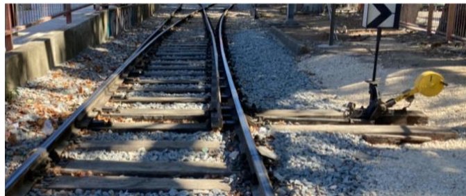
Figura 3 – AMV manual do lado Sul da atual Estação de Alcântara Terra
