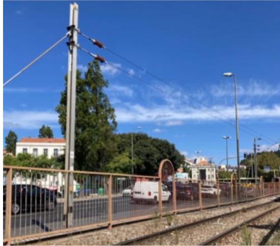
Figura 2 – Terminação da eletrificação da Linha de Cintura
