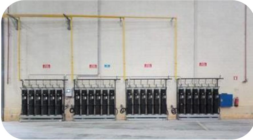
*Fotografia 3 - Sistema de Extinção Por CO2*
