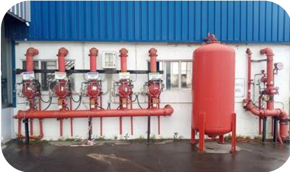
*Fotografia 2 – Posto de Comando Difusores água/espuma do Edifício Evaporador*
