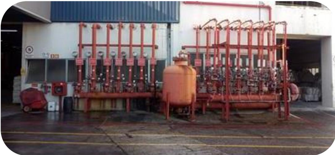
*Fotografia 4 - Posto de Comando do Edifício dos Reactores: Sprinklers e em redundância difusores água/espuma nos Reactores 1 a 10*
