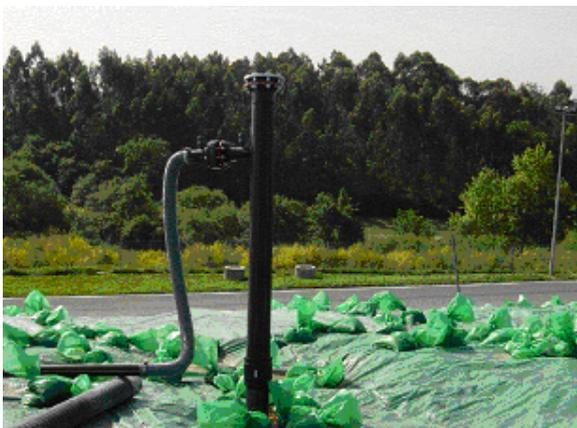
**Figura 13 - Poço de biogás**
