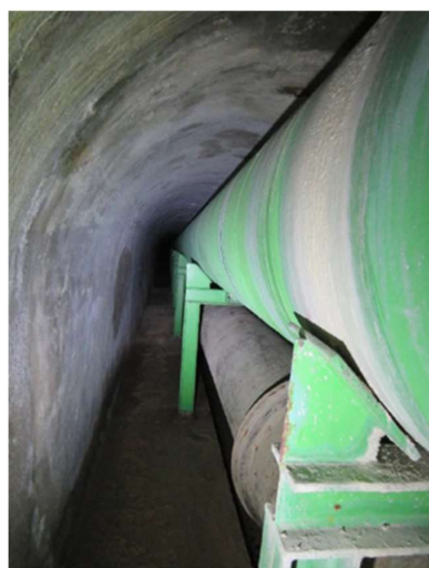
Figura 13 – Vista do interior da Interferência 54
