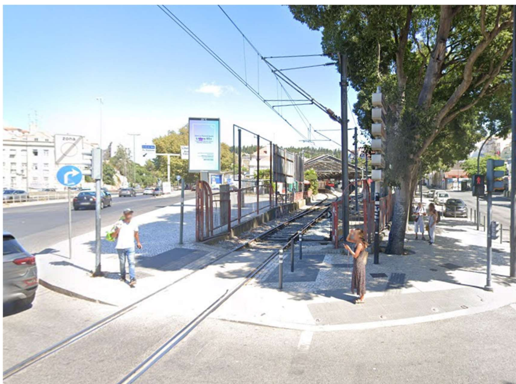
Figura 48 - Troço Linha Férrea afetada
