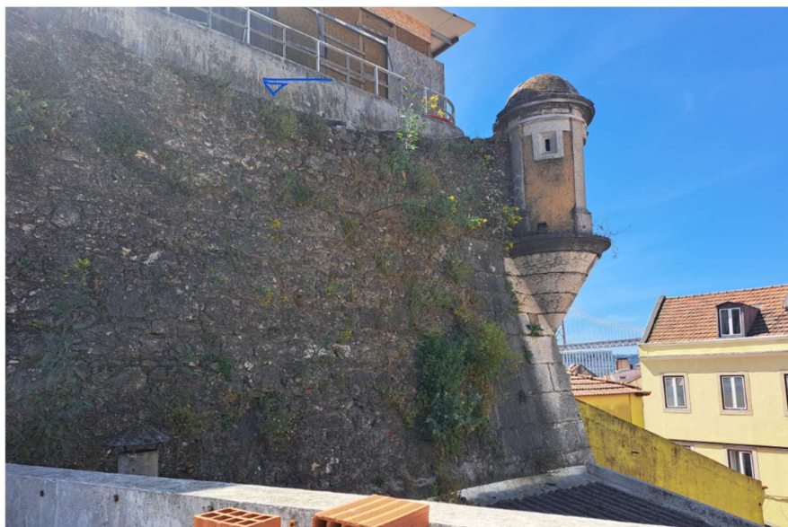
Figura 46 - Baluarte do Livramento
