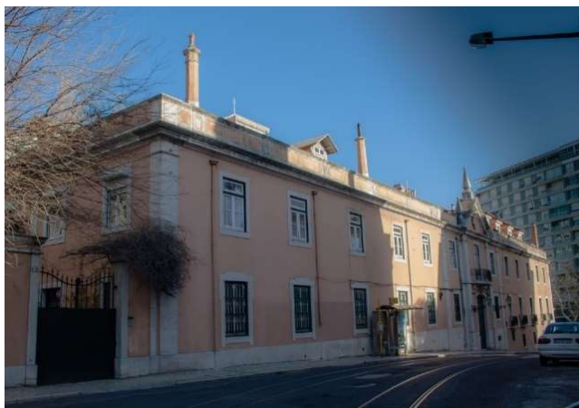
Figura 30 - Palácio Anadia, fachada principal
