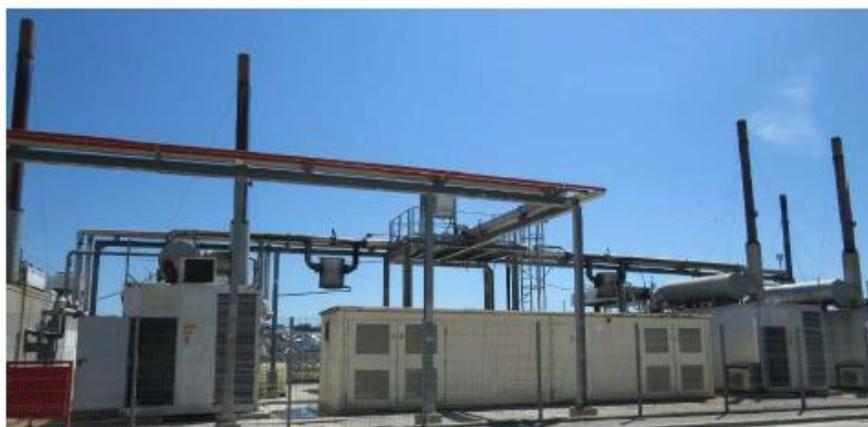
Figura 6-3 – Cogeneradores do sistema de aproveitamento energético do biogás da CITVRSU
