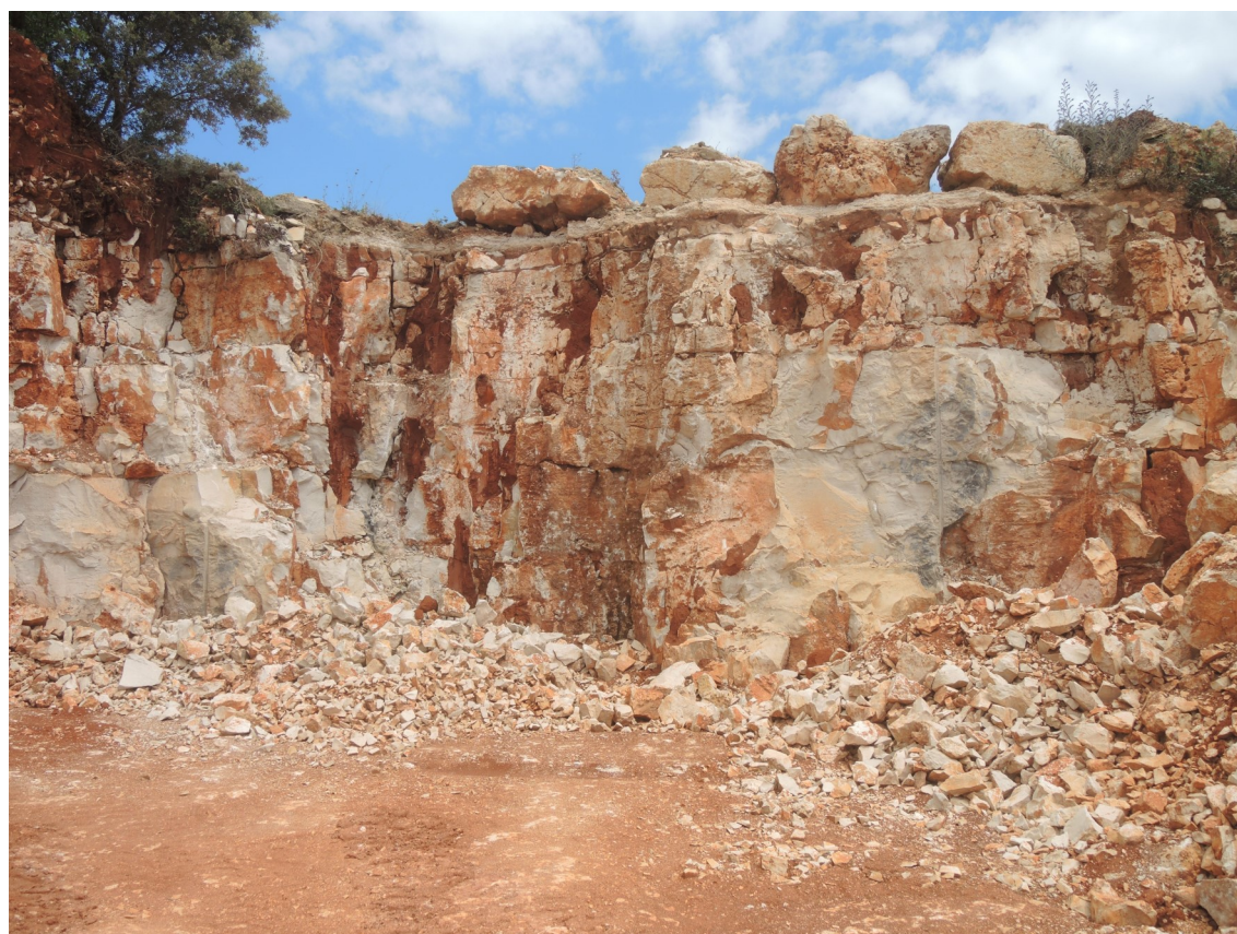
Fot. 9 e 10 – Bancada de exploração localizada junto ao limite SE e pormenor da fracturação de superfície.
