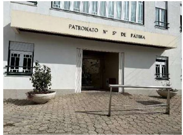
Figura 308 - Patronato de Nossa Senhora de Fátima (junto ao início da intervenção)
