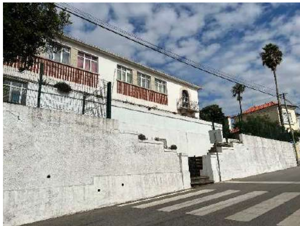
Figura 4.325 - Escola Básica de Travassô (na proximidade do km 12+450)
