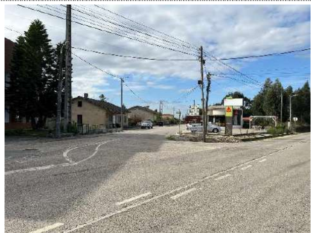
Figura 4.288 - Espaços de restauração (ao km 13+500)
