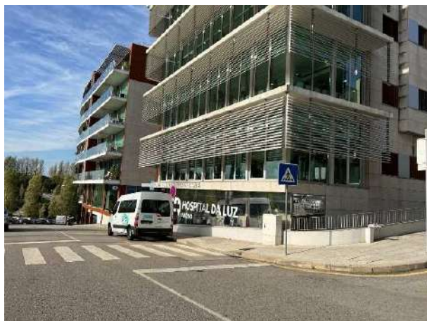
Figura 4.303 - Hospital da Luz, Força (na proximidade do início da intervenção)
