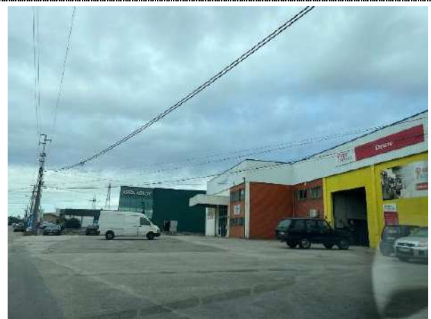
Figura 4.284 - Espaços comerciais e industriais junto à M578 (final do traçado)
