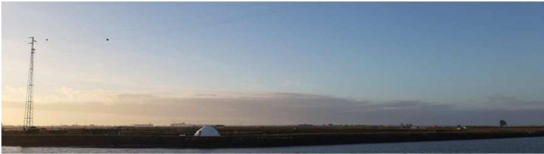
Figura 4.195 – Vista para noroeste sobre a ria de Aveiro (salinas e tanques de piscicultura)
