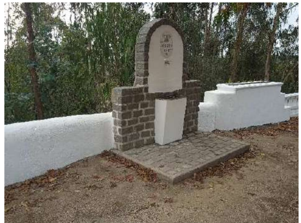
Figura 4.314 - Fontanário público (na proximidade do km 11+000)
