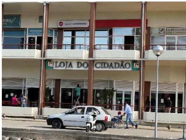
Figura 4.301 - Loja do cidadão, Força (na proximidade do início da intervenção)
