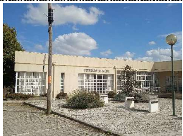
Figura 4.306 - Extensão de Saúde de Requeixo (na proximidade do km 9+925)
