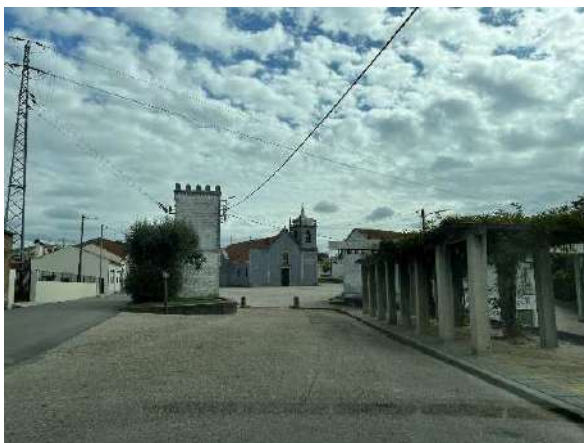
Figura 4.317 - Igreja de São Miguel, Travassô (na proximidade do km 12+450)
