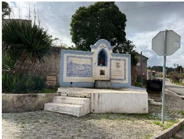
Figura 4.313 - Fontanário público (na proximidade do km 12+450)
