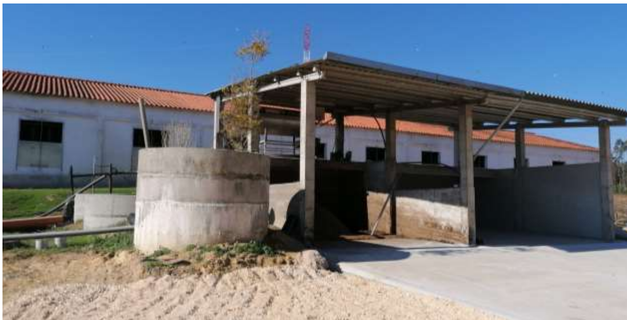
Tanques receção e nitréira
