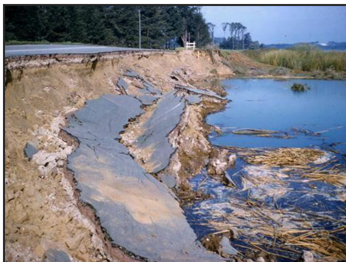
Figura 20 – Rotura de fluxo desenvolvida no bordo de uma estrada junto ao lago Merced em São Francisco, durante o sismo de 1957 (Fotografia de M. G. Bonilla dos USGS in www.usgs.gov ).
