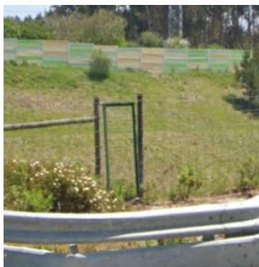
Figura 2.2 - Imagem de porta basculante para acesso a linhas de água.
