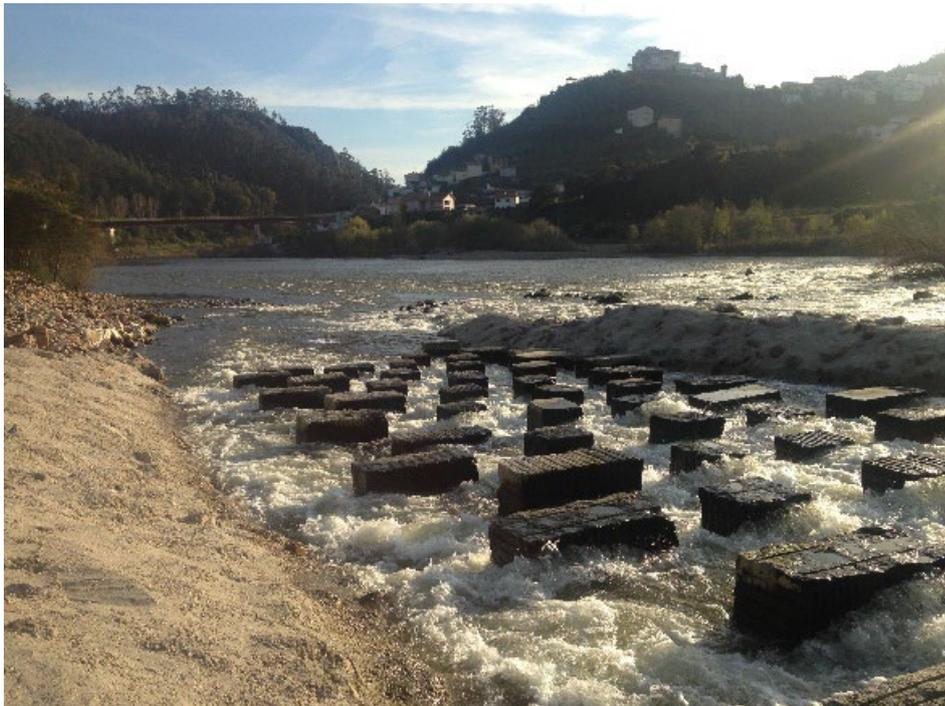
**Foto 5.2 – Passagem para peixes do açude de Penacova construída por blocos de betão (projeto AQUALOGUS).**
