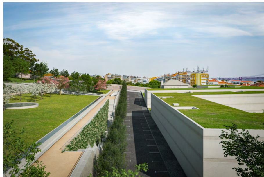
Traversa Nova | vista poente-nascente
