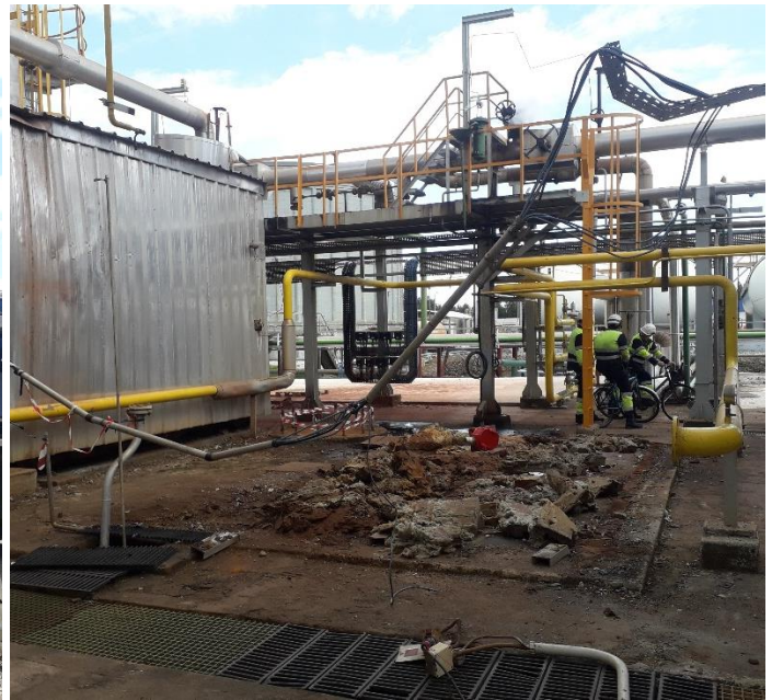
Figura 3: Localização após remoção do equipamento.
