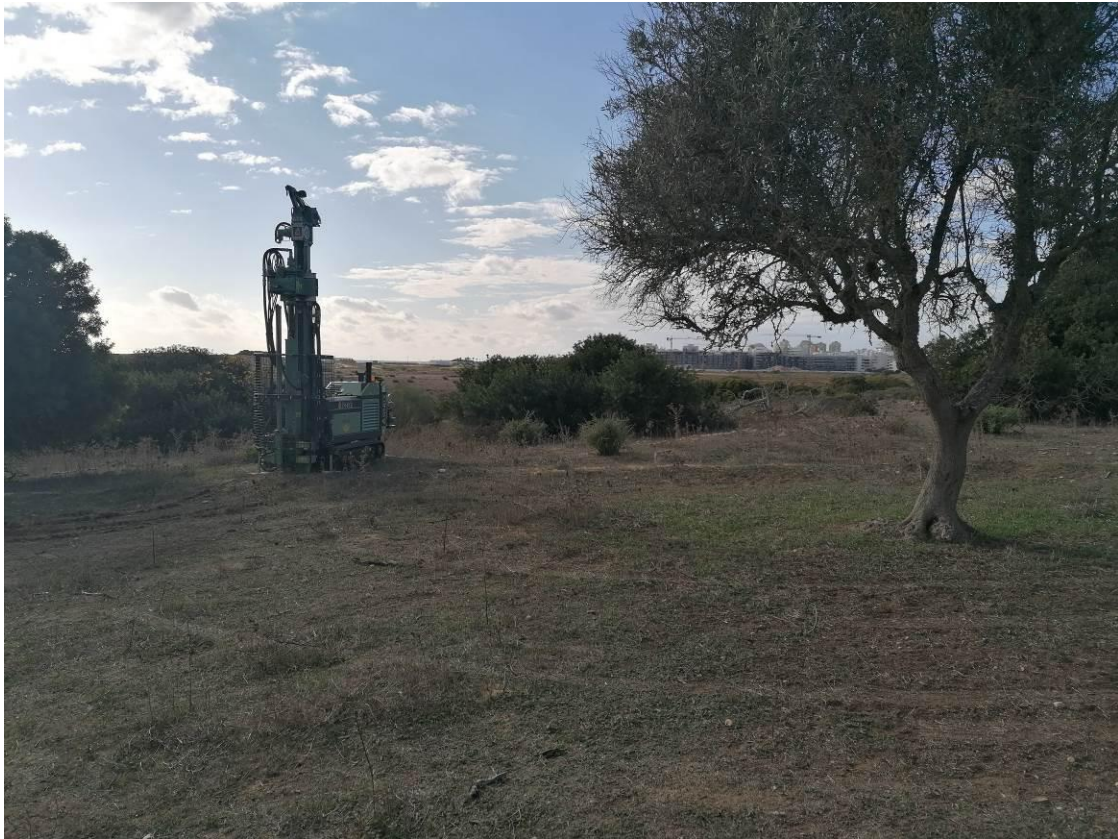
Fotografia 1. Perfuração de uma sondagem.
