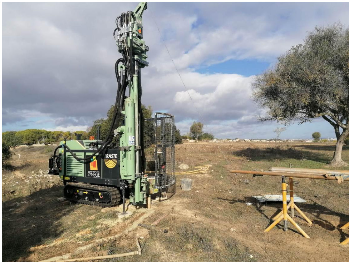
Fotografia 2. Equipamento de perfuração.
