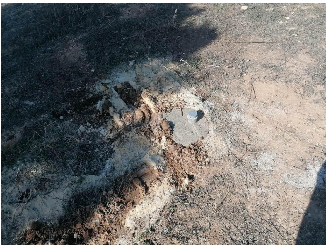
Fotografia 6. Finalização de uma sondagem.
