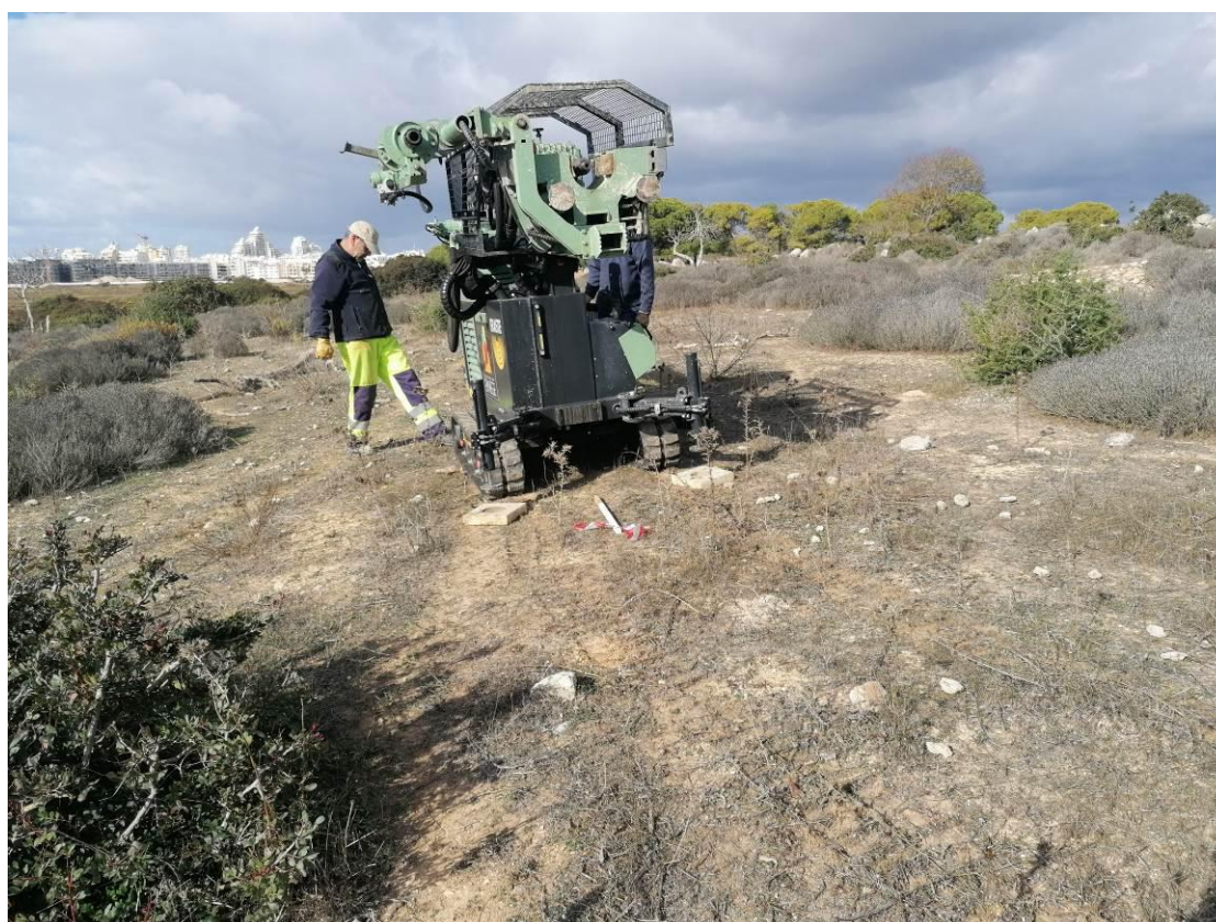
Fotografia 4. Assentamento do equipamento de perfuração.
