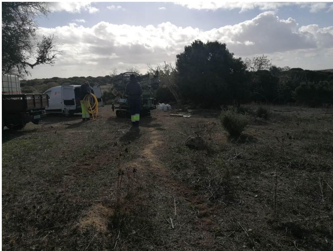
Fotografia 3. Deslocação da máquina perfuradora para outro ponto de perfuração.
