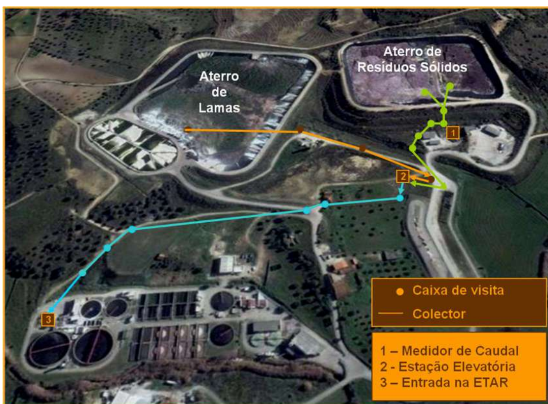
Figura 10 - Rede de drenagem dos lixiviados, desde as células do aterro até à entrada da ETAR.
