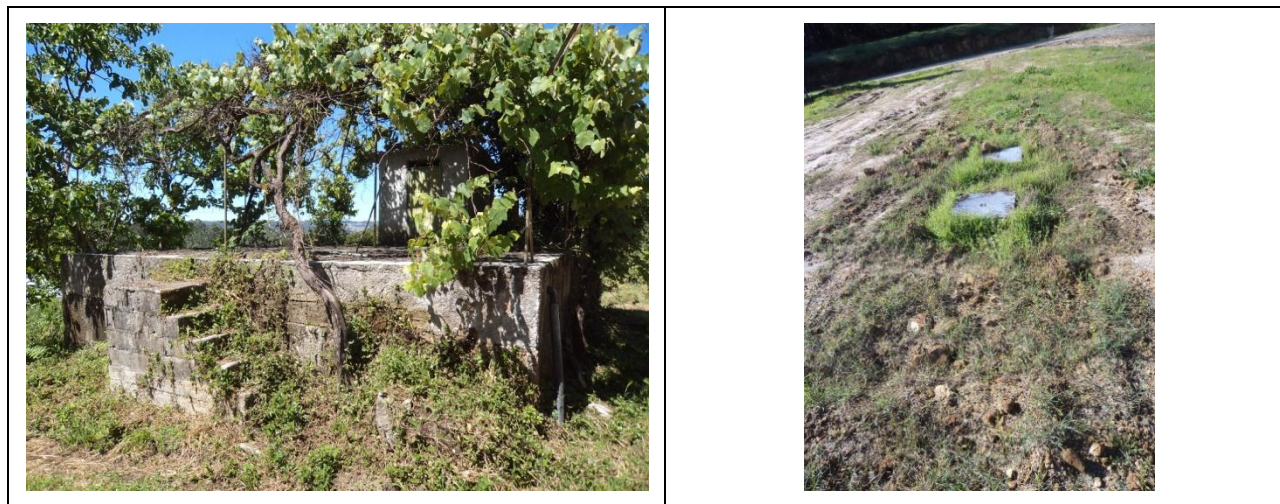
Figura 6 – Depósito de água sobrelevado (à esquerda) e poço absorvente da fossa ES2 (águas residuais domésticas).
