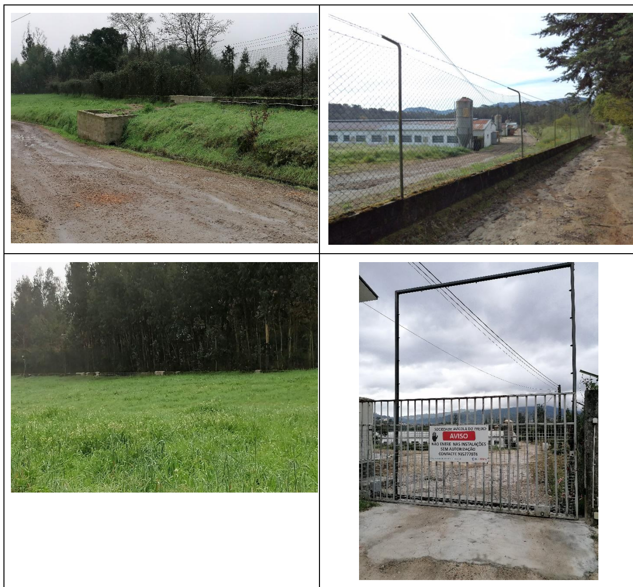
Figura 5 – Extratos da vedação exterior do perímetro da exploração complementada com barreira arbórea/arbustiva.
