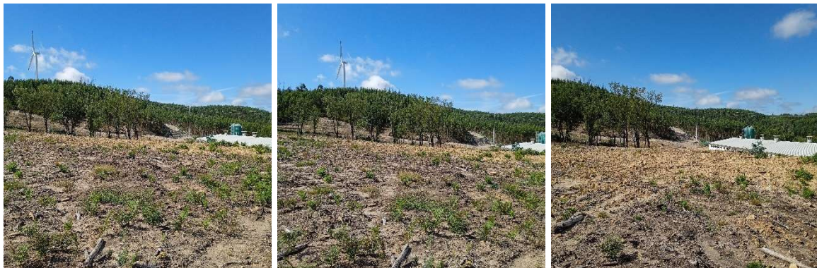
Foto 12: Vista geral da área de implementação do projeto (construção do terceiro pavilhão).
