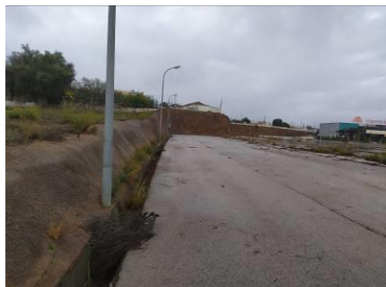
Fotografia 4. Perspetiva dos acessos e taludes impermeabilizados.
