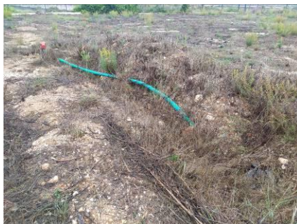
Fotografia 5. Vala de instalação de canalizações a céu aberto.
