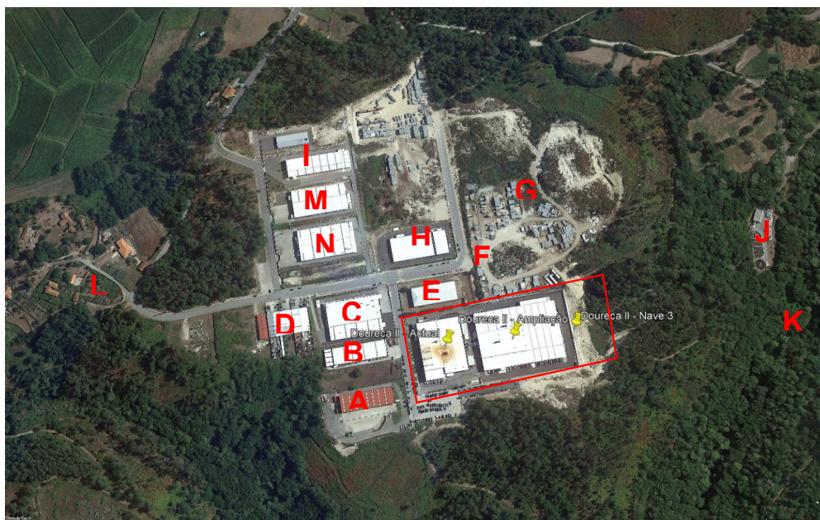
Figura 1: Doureca - Unidade II – zona de implantação e envolvente (fonte Google).
