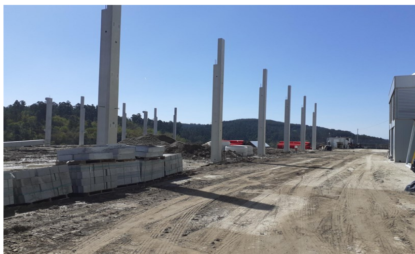
Figura 2: Doureca – Unidade II: Edifício 3 (em construção).
