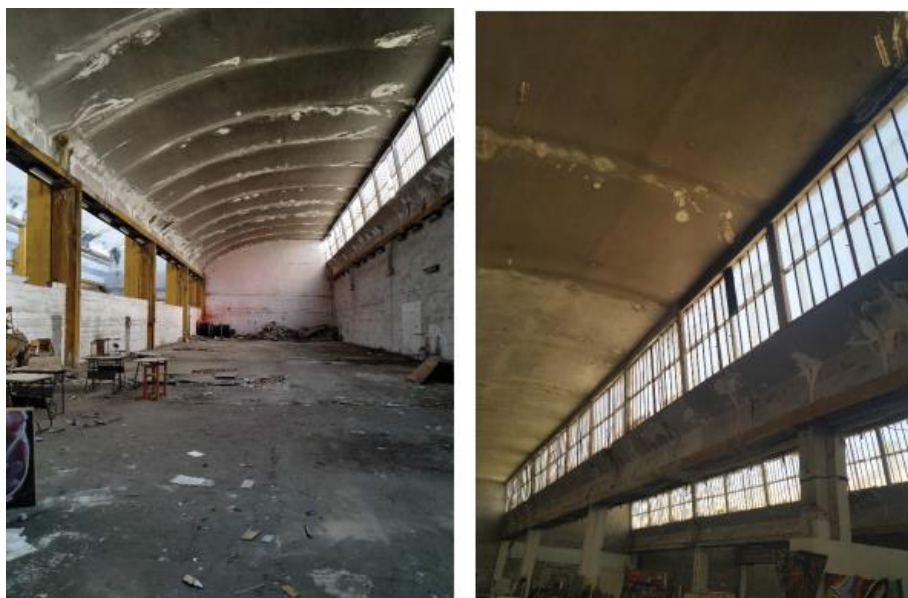
Figura 4.3.1 – Exemplo dos edifícios a demolir.
